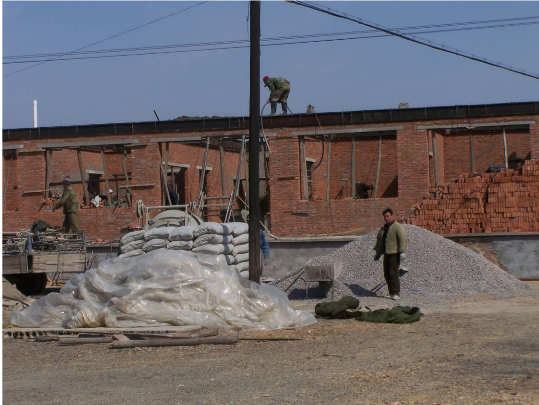
红沿河镇周边村民居民兴建房屋
