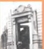
Esquina noroccidental, fachada del edificio "Banco del Ruiz" destruido en el incendio de 1926
