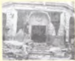
Acceso al Palacio Nacional destruido en el temblor de 1962
