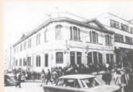
Esquina sur occidental, fachada remodelada (sin balcones) Café El Polo. 1970
