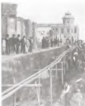
Costado occidental, después del incendio, banqueros 1927
