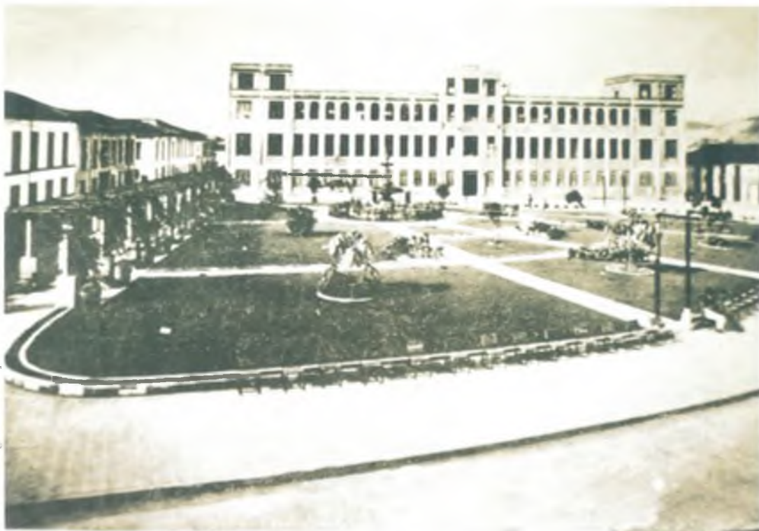
Parque de Los Fundadores y Colegio de Cristo en proceso de construcción
