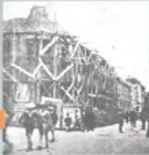
Proceso constructiva, 1934 Compañía Colombiana de Tabaco
