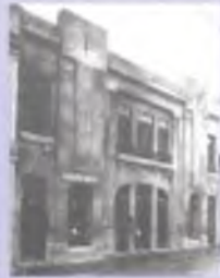
Edificio de la Sra. Zoila R. de Hoyos, 1936
