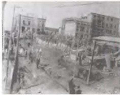
Proceso constructivo, cimentación, 1926
