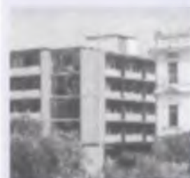
Banco del Comercio, 1960, diseño Arq. Jorge Arango Uribe, demolido luego del terremoto de 1979
