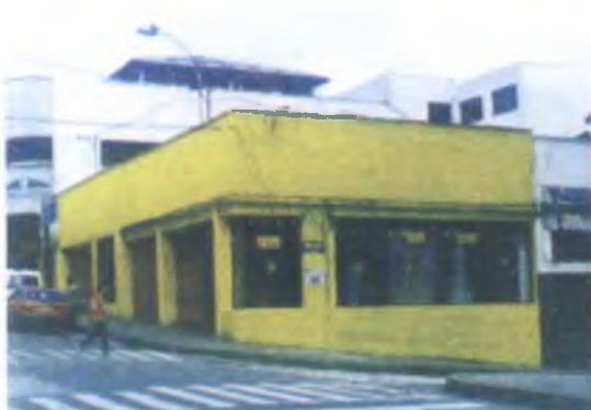
Estado actual, cra 22 calle 18, 2000
