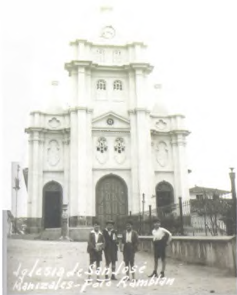
Templo de San José, fachada Archivo fotográfico: Parques/San José n° 92
