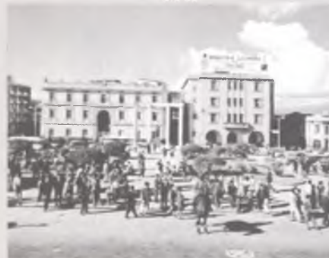
Nótese la construcción parasita en la terraza; retirada en la mitad de la década de los años 80
