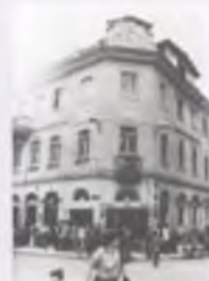
Esquina suroriental, edificio Estrada 1970
