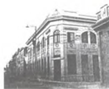
Esquina soroiental Edificio del Sr. Abel Mejía, 1928
