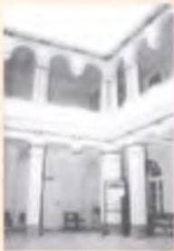
Patio en claustro, 1997
