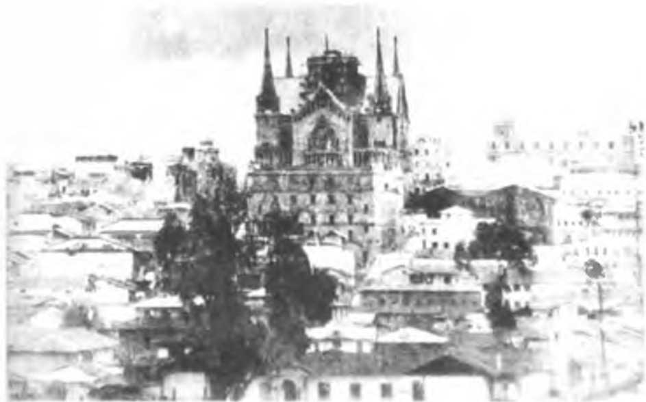
Proceso constructivo del Tercer Templo o Catedral 1936 aproximadamente.
