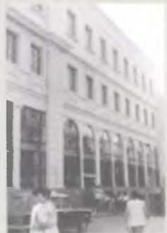
Costado norte Edificio Librería Gutiérrez R., 1999 Fachada remodelada
