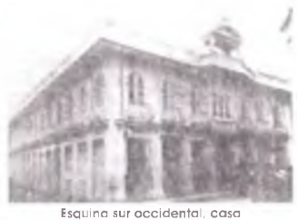
Esquina sur occidental, casa de Felix María Salazar, M 65 p. 04, antes del incendio de 1925
