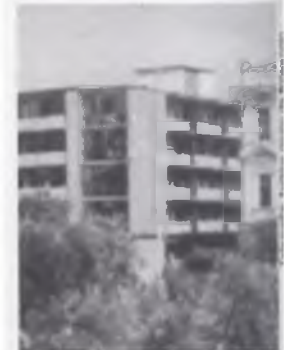
1952 Banco del Comercio Manizales; esquina noroccidental Plaza de Bolívar; demolido luego del terremoto de 1979
