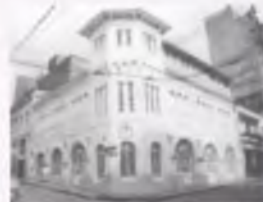
Predio con edificación parasita
