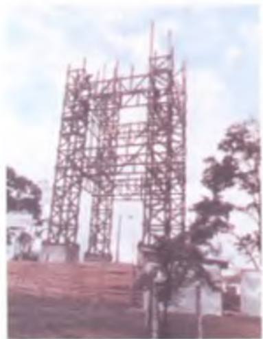
Torre de Herveo, proceso de montaje en Manizales
