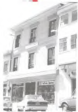
Costado norte, p. 02, remodelada años 90
