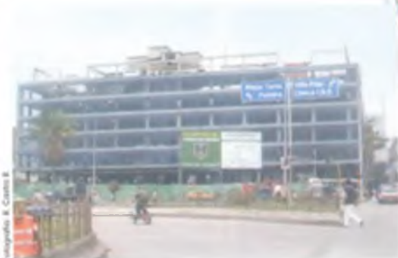
Alcaldía Municipal de Manizales, proceso de demolición 2001
