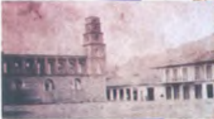
Proceso constructivo Catedral de Pereira
