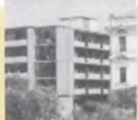
Banco del Comercio, 1960, diseño Arq. Jorge Arango Uribe, demolido luego del terremoto de 1979
