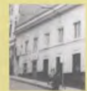
Esquina noroccidental, antigua Pensión Escobar
