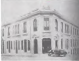
Casa de Matilde J. Viuda de Echeverri e Hijos. p. 09/10 (Edificio Tamanaco), 1927
