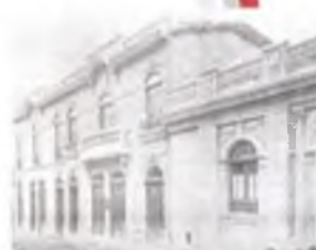
Costado occidental p. 03 del sr. Gerardo Arlas Mejía y el p. 04 del sr. J. P. Echeverry. Cll 21 entre cras 23 y 24 (cll 13 entre cras 13 y 14),
