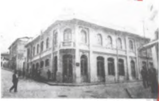
Esquina nororiental, p. 07, Edificio del Sr. Julio Restrepo, 1936
