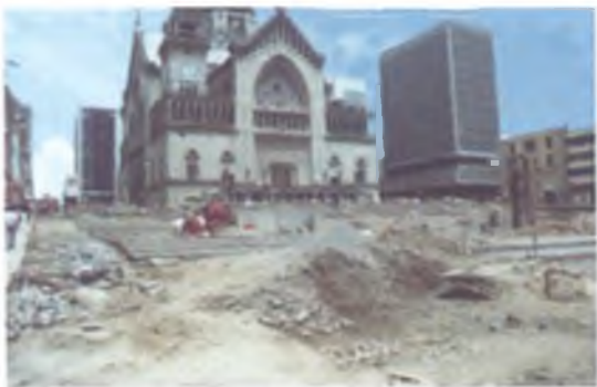
Banqueo, proceso constructivo, 1983
