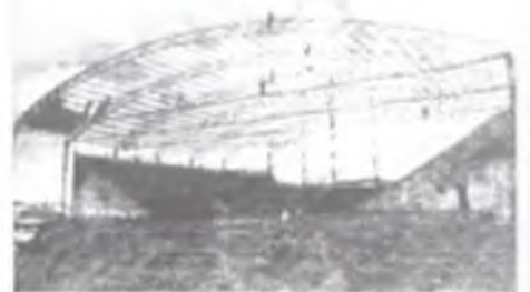
Construcción Coliseo Mayor de Manizales, 1957
