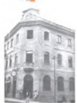
P. 06, almacén del Sr. Diego Estrada, construyó Papio y Bonarda
