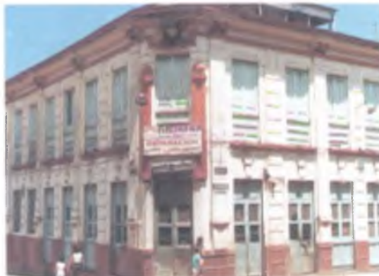
Cra 15 c 23 Casa construida por Miguel Giraldo en Armenia Quindío, (demolida)
