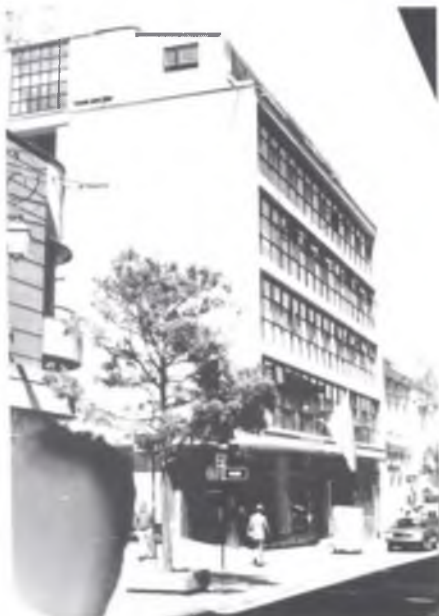
Edificio de Telecom cra 23 c 20. Manizales, años 50
