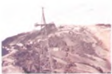
Sistema, tramo del Cable aéreo
