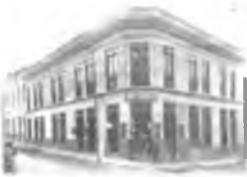
Esquina suroriental. Casa del Sr. Santiago Sanín y almacén de Jorge Jaramillo M. 1928
