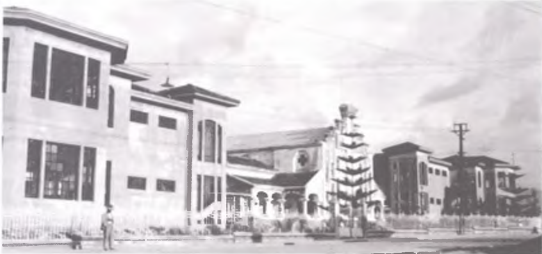
Hospital y asilo de ancianos, diseño Arq. Pablo de la Cruz, colaborador Ing. Guillermo Ledher S. 1933
