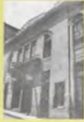
Edificio de Joel y Eduarda Salazar Posterior Mullers Hotel, 1936
