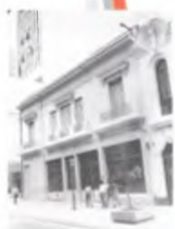
P. 05, demolida en 1979, predio 04
