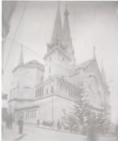
Abside, Fachada posterior cra 23, 1940
