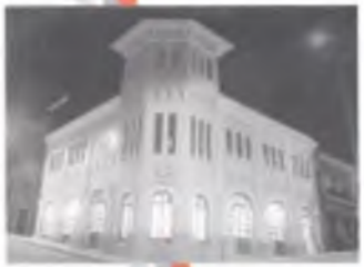
Cra 24 Cll 24 esquina suroriental (Cr 14 Cll10) Remodelación 1998. Sede Comfamiliares, p. 08
