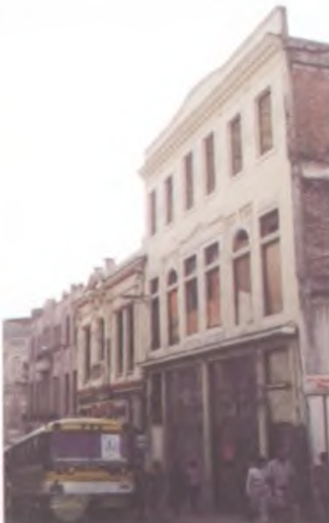
Edificio cra 21 (demolido 1993)
