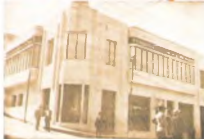
1936 Edificio Sede de la Compañía Colombiana de Tabaco Cra. 22 calle 21 esquina nororiental
