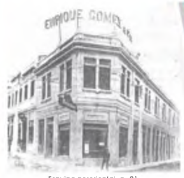
Esquina nororiental, p. 01, almacén Sr. Enrique Gómez, 1936
