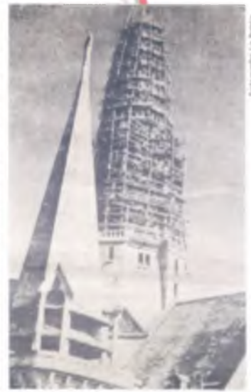
Construcción aguja central, 1939
