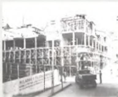
Hotel Escorial. Proceso de construcción 1935
