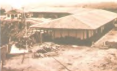
Estación de El Cable, nótese la ausencia del cuerpo central y/o “palomera” 1925 aproximadamente
