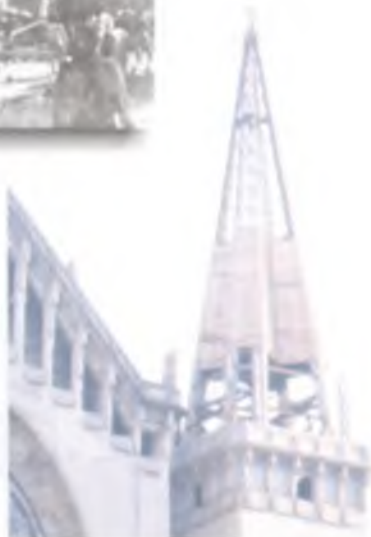
Reconstrucción, 1988. Ing. Harold Estrada, otros
