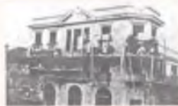
Proceso constructivo, Ulen & Company, 1927
