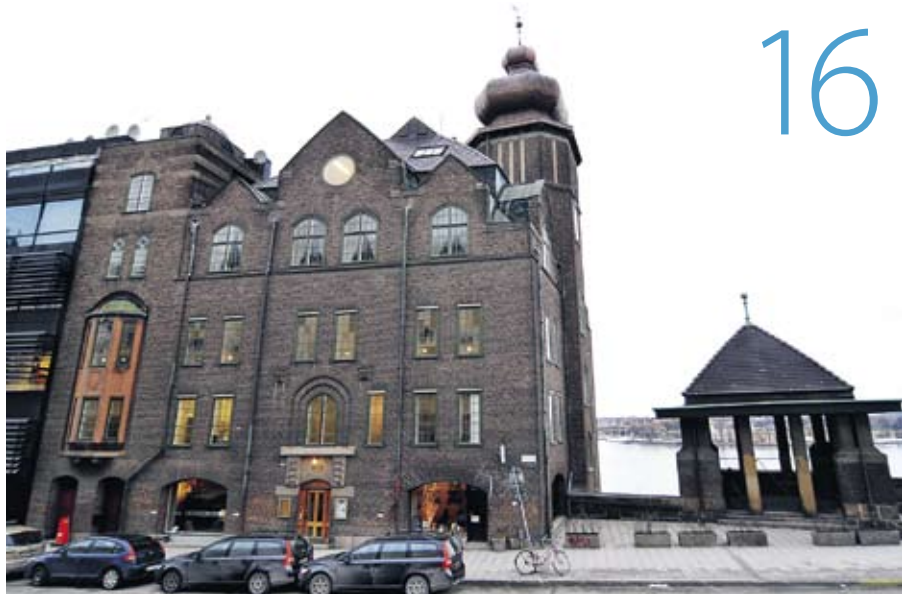
Sjömansinstitutet på Katarinavägen 19, ett hus med en brokig historia.
