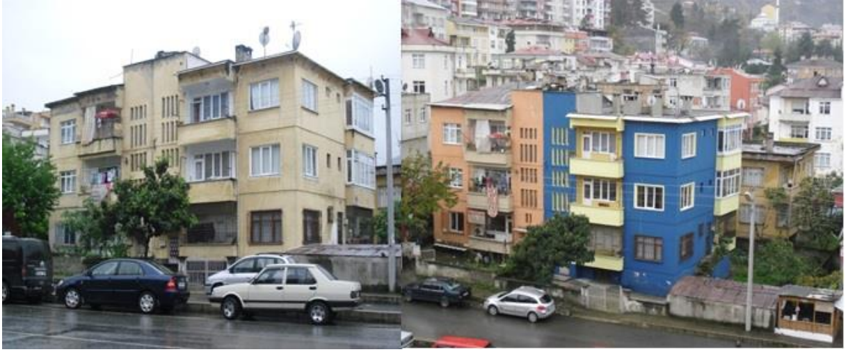
Fotoğraf H.2-Boyasız ve Sivasız Bina Çalışmaları
