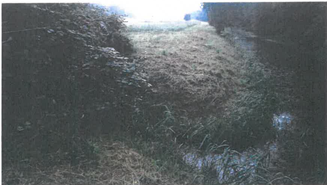
Bild 6: Bahnverbindungsgraben mit Anschluss eines Entwässerungsgrabens
