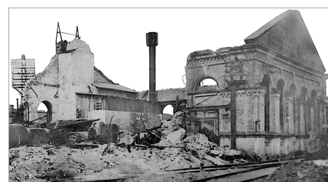
Взорванная парокотельная завода НКПС
