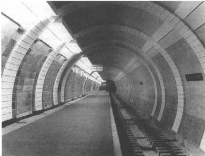
169. Nikolaj Ladovskij. U-Bahnhof „Dzerzinskij-Platz“, Unterirdischer Saal 1935.
