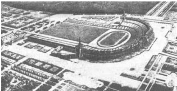
186. Nikolaj Kolli, Zentralstadium in Moskau.
