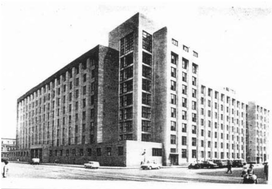
80. Noj Trozkij. NKVD-Gebäude, Leningrad, 1931.
