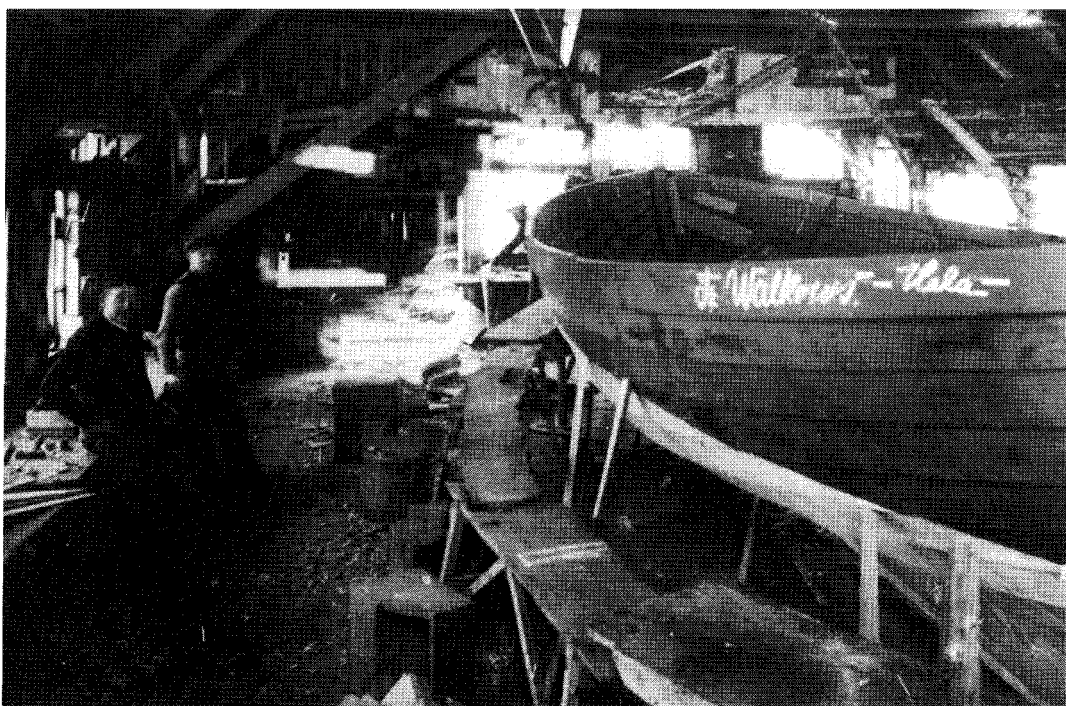
Dæksbåd til Hela under bygning på H. P. Hansens Bådebyggeri, Svaneke, byggenummer 178. Arbejdet blev påbegyndt den 17.3.1916.
