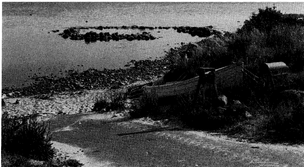
Rester af havneanlæg opført 1851 tæt under land vest for Arnager havn. Anlægget tilsandede dog. I 1884 anlagde man efter tegninger af Hans Zartmann den nuværende øhavn med en 185 meter lang adgangsbro. Herefter kunne sandet passere frit med strømmen uden større problemer.
