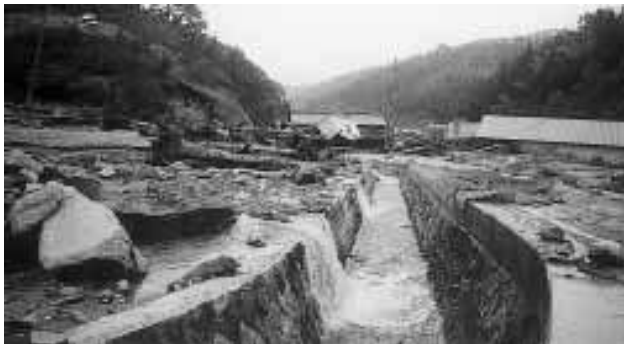
図3 県道赤花薬王寺線に土石流 2004年12月「広報たんと」NO537より
