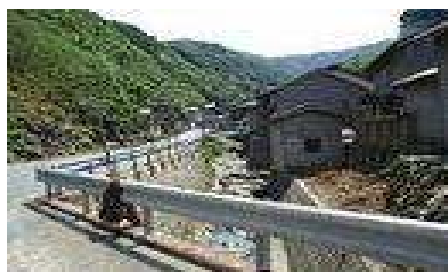
写真1. 田久日、主要道路
