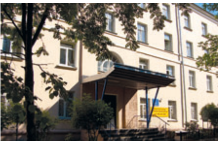
Здание ТСП № 5 ГБОУ СПО КАС № 7 (бывший МНМП)
