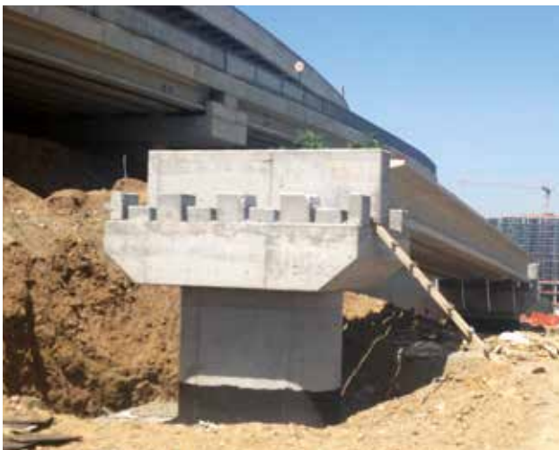
Für die Passagiere der Bahn wird von einer Plattform in der 2. Etage aus der Zugang zur Einkaufs-Mall geschaffen.
