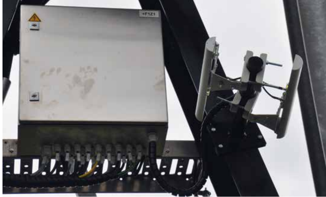
WLAN-Antennen samt Clients: Die Vorteile beim WLAN-Übertragungssystem bestehen vor allem darin, dass neben steuerungstechnischen Sicherheitssignalen in AK4 ebenfalls Audio- und Videosignale in HD-Qualität übertragen werden können.
