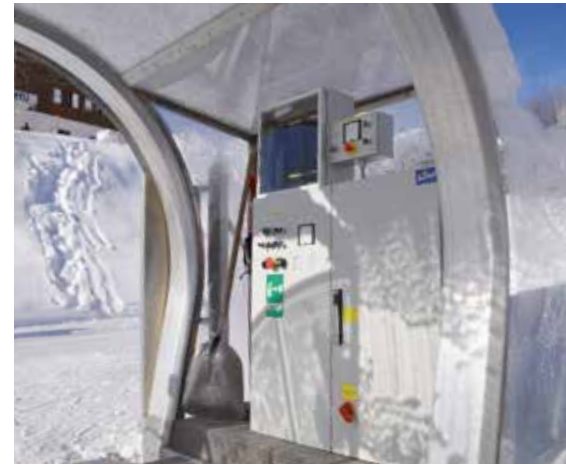
Der überdachte Ausstiegsbereich mit Verbreiterung für E-Box und Steuereinheit
