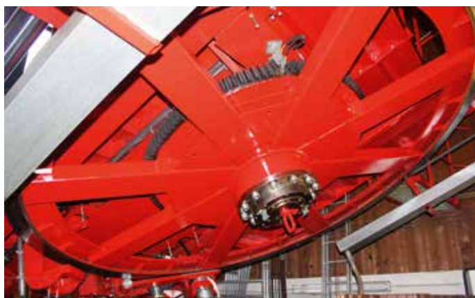
Die gesamte Seilbahn-Technik (Laufwerk, Antriebsscheiben, Gehänge etc.) wurde von STEURER general-saniert.
