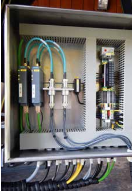
WLAN-Antennen samt Clients: Die Vorteile beim WLAN-Übertragungssystem bestehen vor allem darin, dass neben steuerungstechnischen Sicherheitssignalen in AK4 ebenfalls Audio- und Videosignale in HD-Qualität übertragen werden können.
