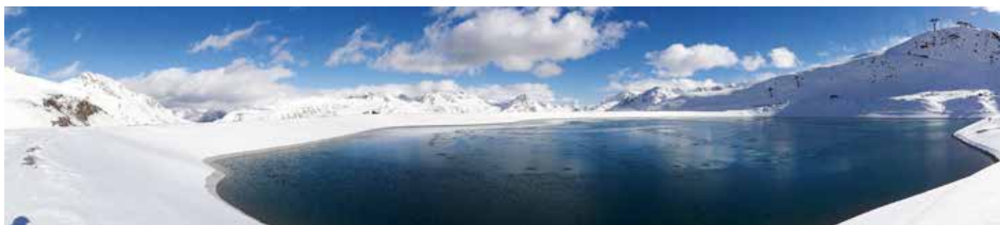
Für die kommende Ski-WM in St. Moritz wurde im Vorjahr der größten Naturspeichersee der Schweiz mit 400.000 m 3 Fassungsvermögen errichtet.
