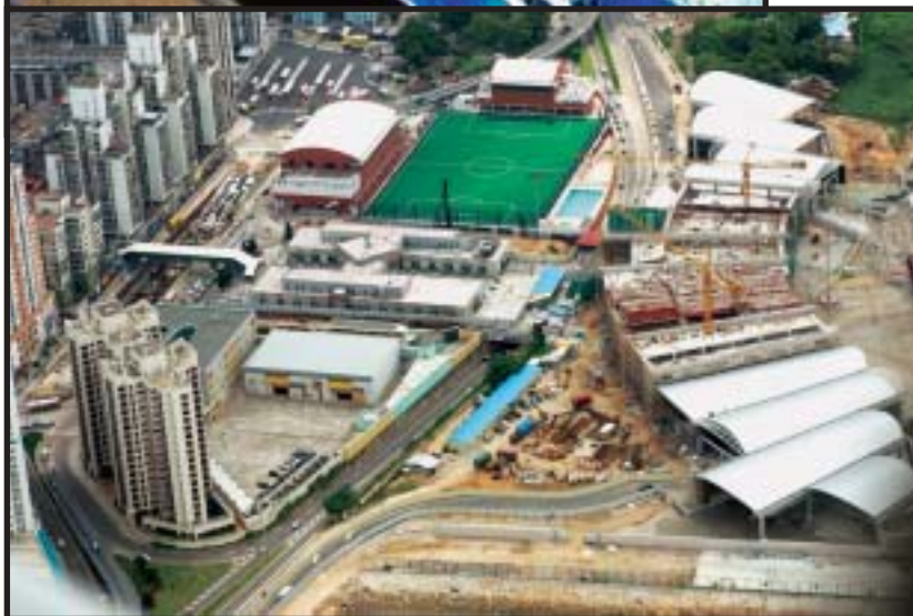
關閘邊檢大 樓工程進行 中
