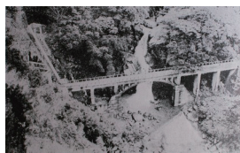
圖19日治時期台北市自來水草山水管橋道(資料來源:《臺灣遞信》)
