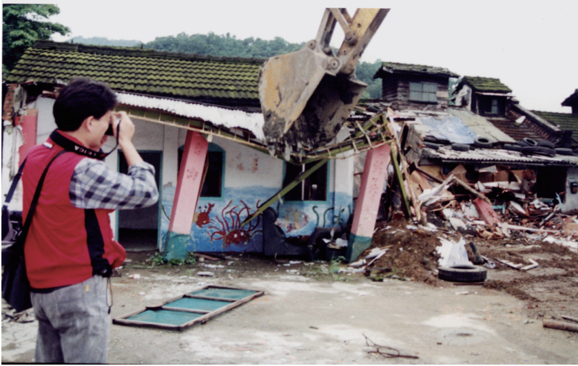
圖一、凌雲五村舊時眷村房舍拆建情形（余為麟先生提供）
