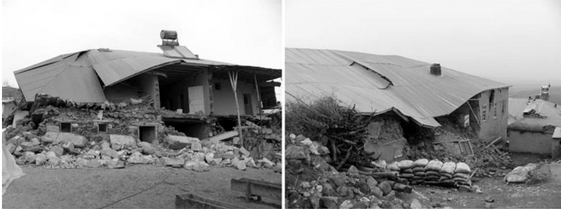
Foto 4: Okçular köyünde taş, kerpiç ve delikli tuğladan yapılan karma yapılar. Bu yapılarda kerpiç bölüm dışında taş ve tuğladan yapılan bölmelerin etkilenmiş olması dikkat çekicidir.
