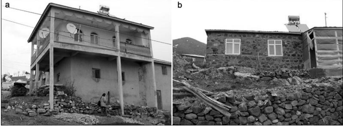
Foto 2: 8 Mart 2010 Kovancılar depreminde zeminin hasar üzerindeki etkisi. a) Okçular köyünde basit usulle yapılmış betonarme binada temel ana kaya üzerinde olduğu için hasar yoktur. b) Yukarı Demirci köyünde ana kaya üzerindeki taş meskende çok az hasar görülmüştür
