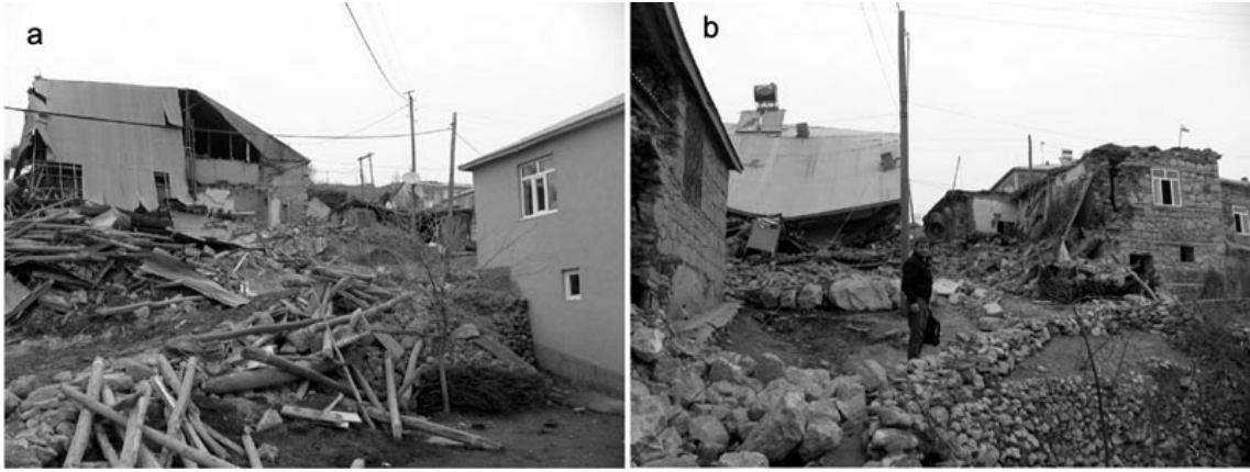
Foto 7: Okçular köyünde yıkılan meskenler çok eski olup meskenler arasındaki sokaklar çok dardır
