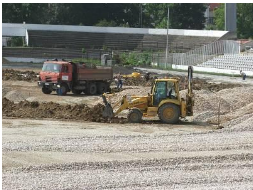
miesto futbalistov a po štadióne prehánali buldozéry, či iné stroje
