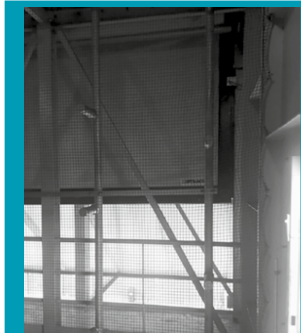
7. KÉP: A LITÉRI LÉGBESZÍVÓT LEZÁRÓ GYORSKAPU FÉLÁLLÁSBAN (BELÜLRŐL NÉZVE) (AZ ELŐTÉRBE JÓL LÁTHATÓ A MADÁRVÉDŐ HÁLÓZÁS ÉS A JÉGMENTESÍTŐ RENDSZER FŰVÓKÁI)
