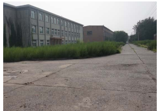
隧道出口现状
