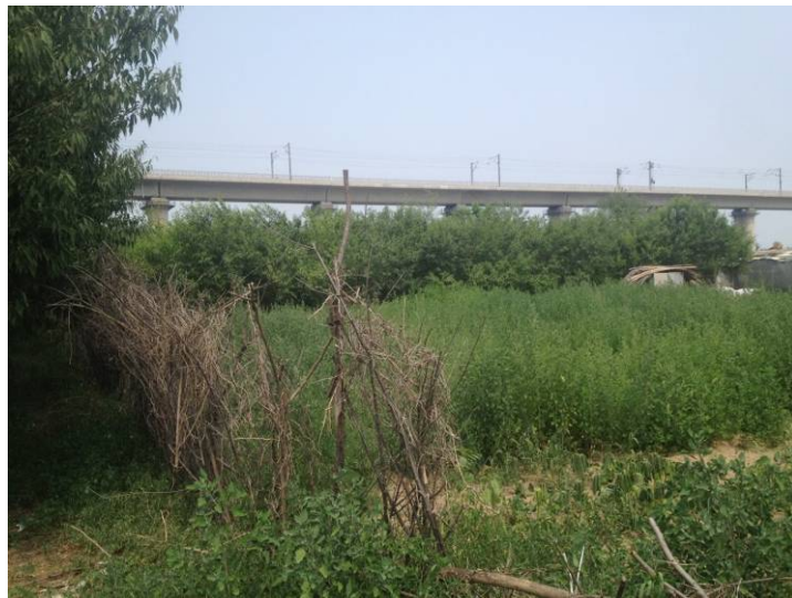
图 7-1 黄村牵引变电所选址处照片
