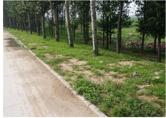
永定河右堤现状
