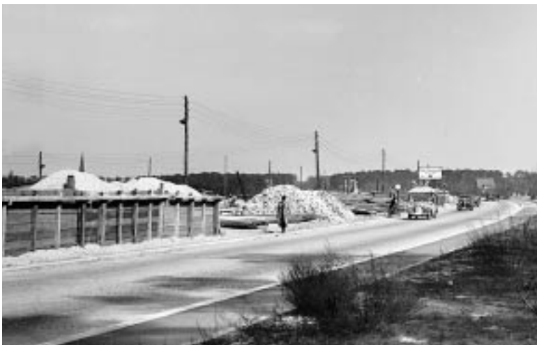
Baustelle an einer Reichsautobahn im Jahre 1939. Foto: Landesbildstelle Berlin
