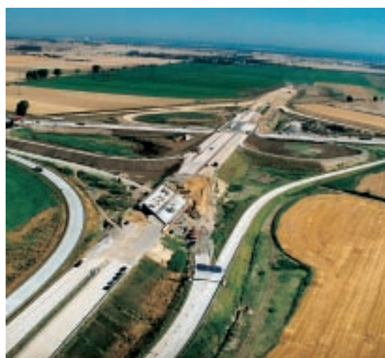
Im Zuge der Erstellung des AK Magdeburg (A2/A14) wurde auf 3,8 km Länge die A2 sechsstreifig ausgebaut.
