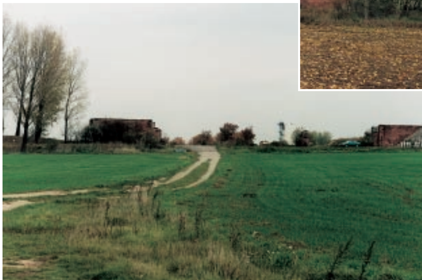
Alte Unterbauten des Ü-Bauwerks B1 über die A14 bei Irxleben (vor 1945).
