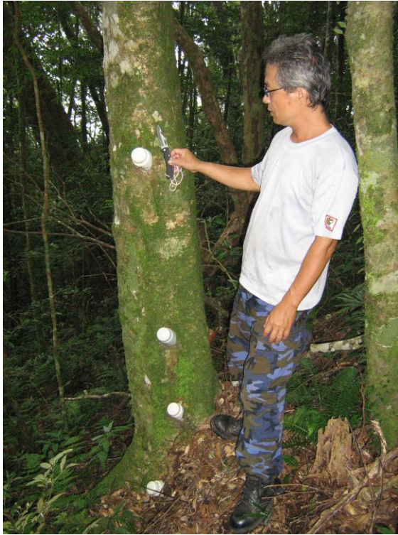
圖2 通電鐵絲網的殘留礙子(說明：攝於油羅山)
