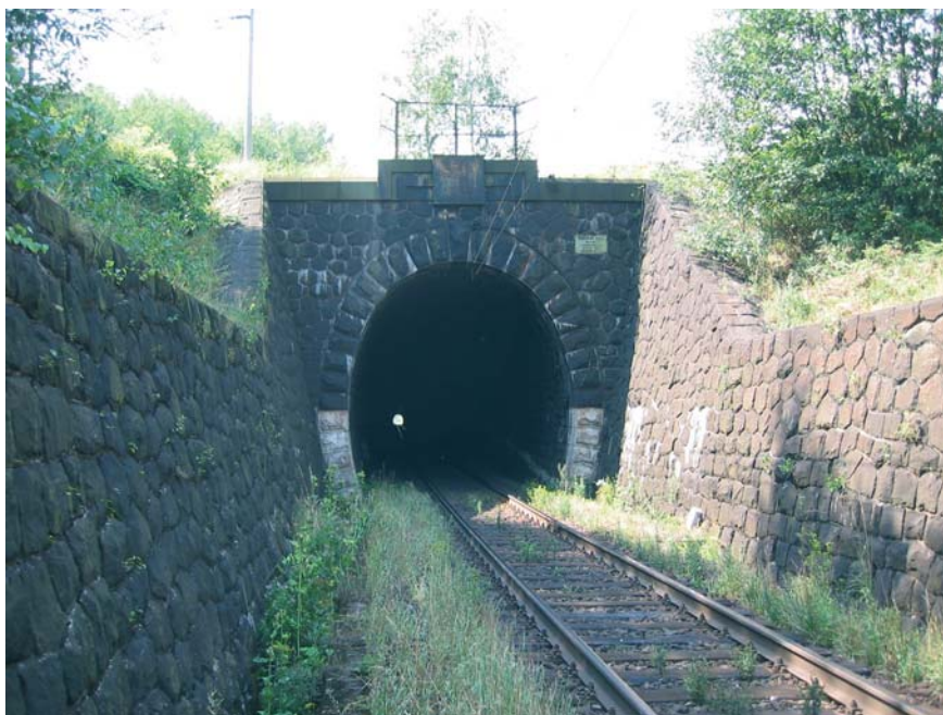
8) Starý Třebovický tunel, stav z roku 2004
