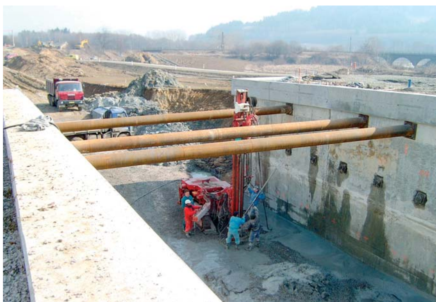
g) Provádění tryskové injektáže z úrovně základové spáry desky dna zářezu
