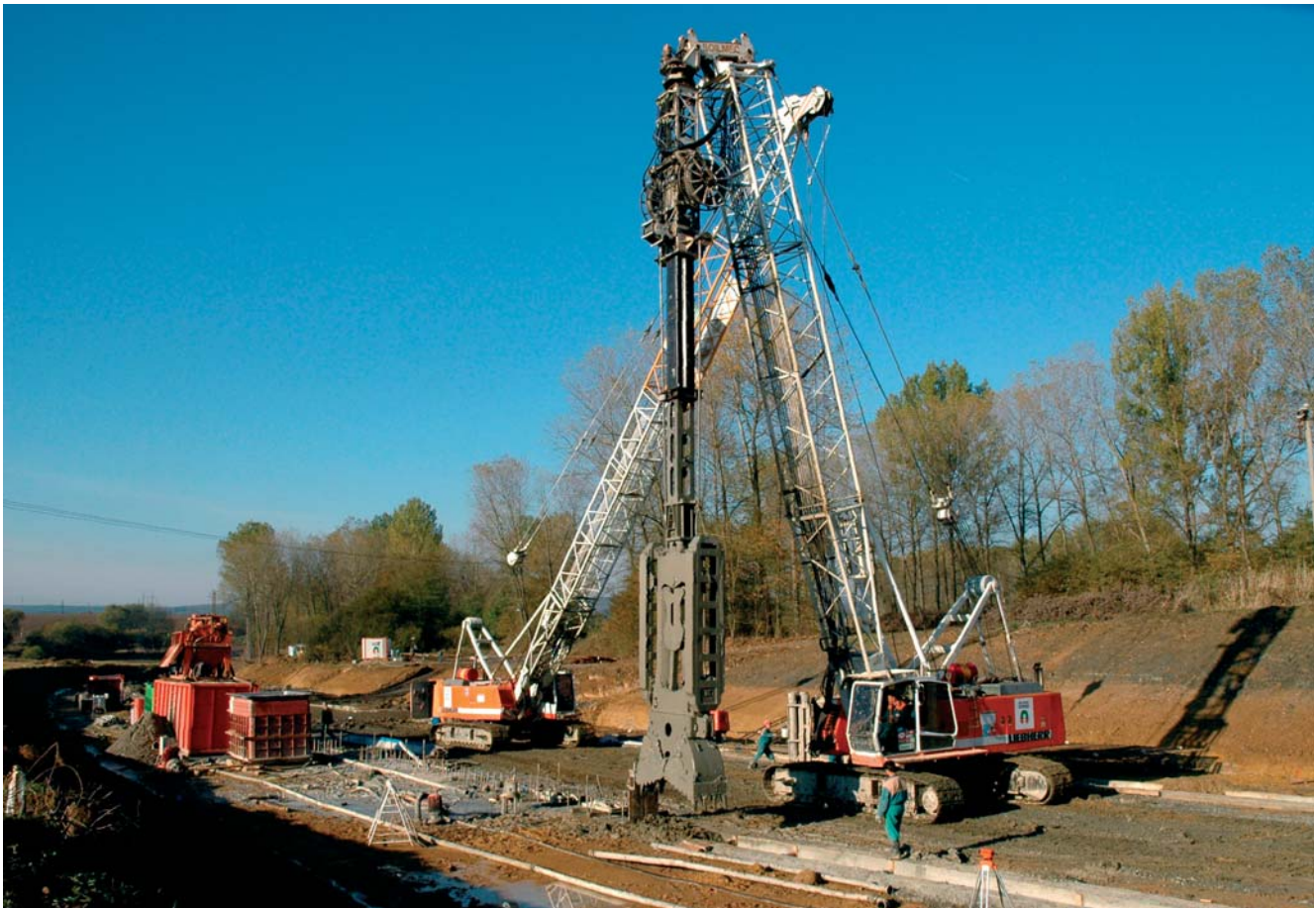
a) Těžba podzemních stěn zárubních zdí
