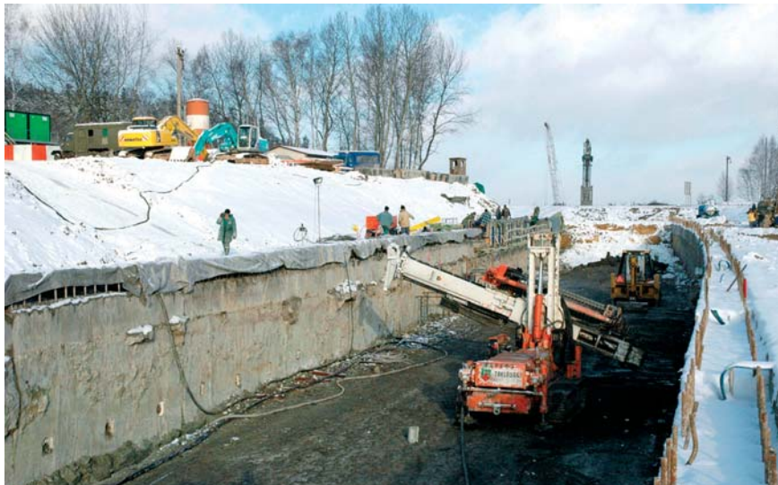
e) Provádění dočasných pramencových kotev v úseku obráceném ke Třebovicím
