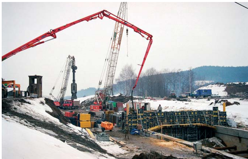
i) Betonáž portálu tunelu od Třebovic
