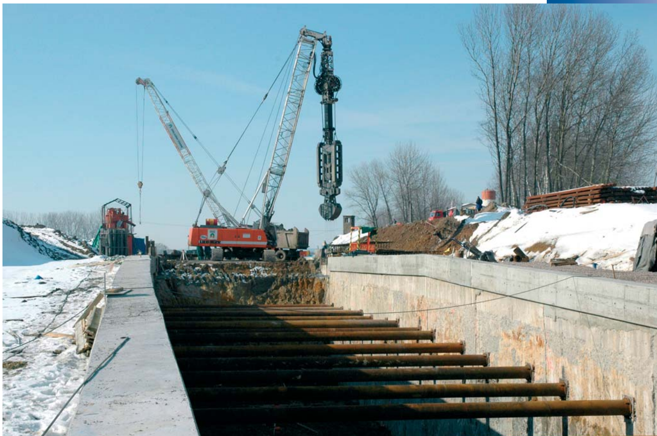
c) Pohled na úsek zárubních zdí rozepřených ocelovými rourami, v pozadí výroba podzemních stěn na objektu tunelu
