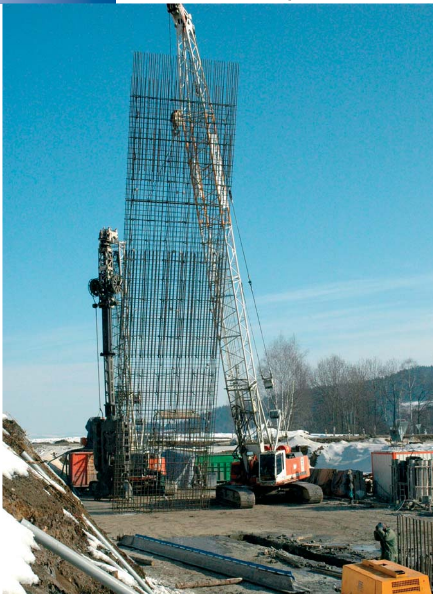
b) Osazování armokoše délky 24, 6 m podzemní stěny konstrukce tunelu
