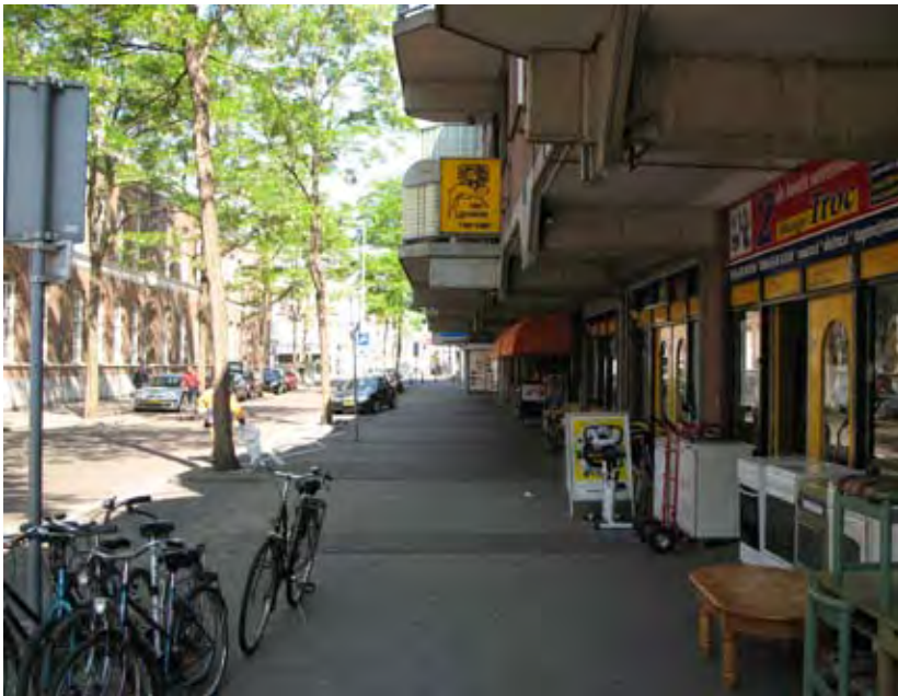
fout voorbeeld: uitkragende balkons
