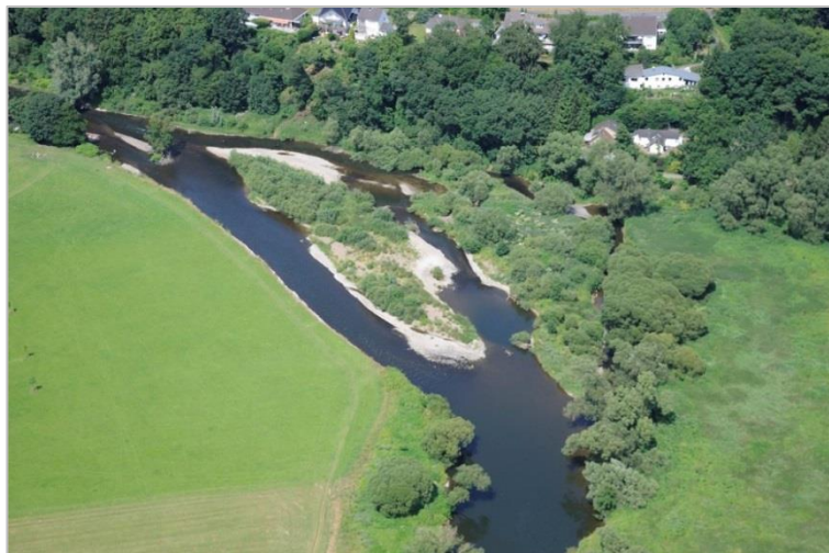
Abb. 11: Die Sieg unterhalb Allner in der PE_SIE_1000 (Quelle: DIE GEWÄSSER-EXPERTEN! 2013).
