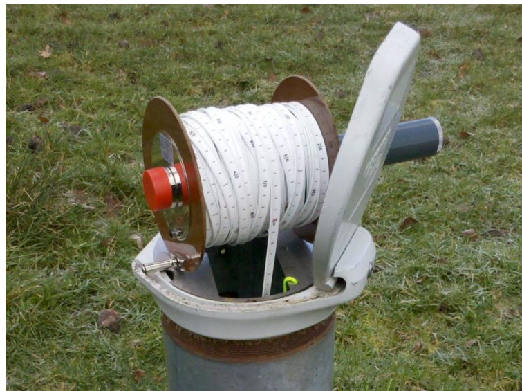
Abb. 16: Grundwasserstandsmessung (Quelle: LANUV NRW).
