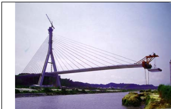
國三高屏溪橋面版吊裝中
