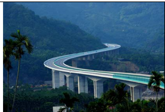
國六國姓路段橋梁
