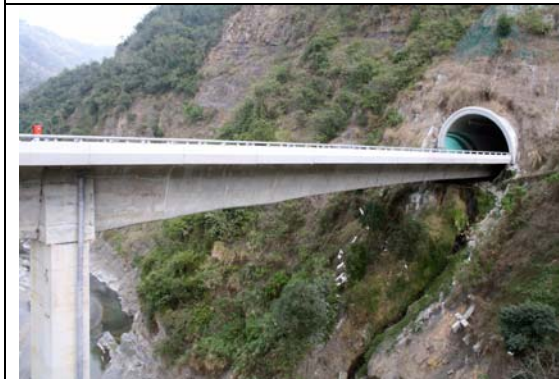
橋梁直接伸入埔里隧道
