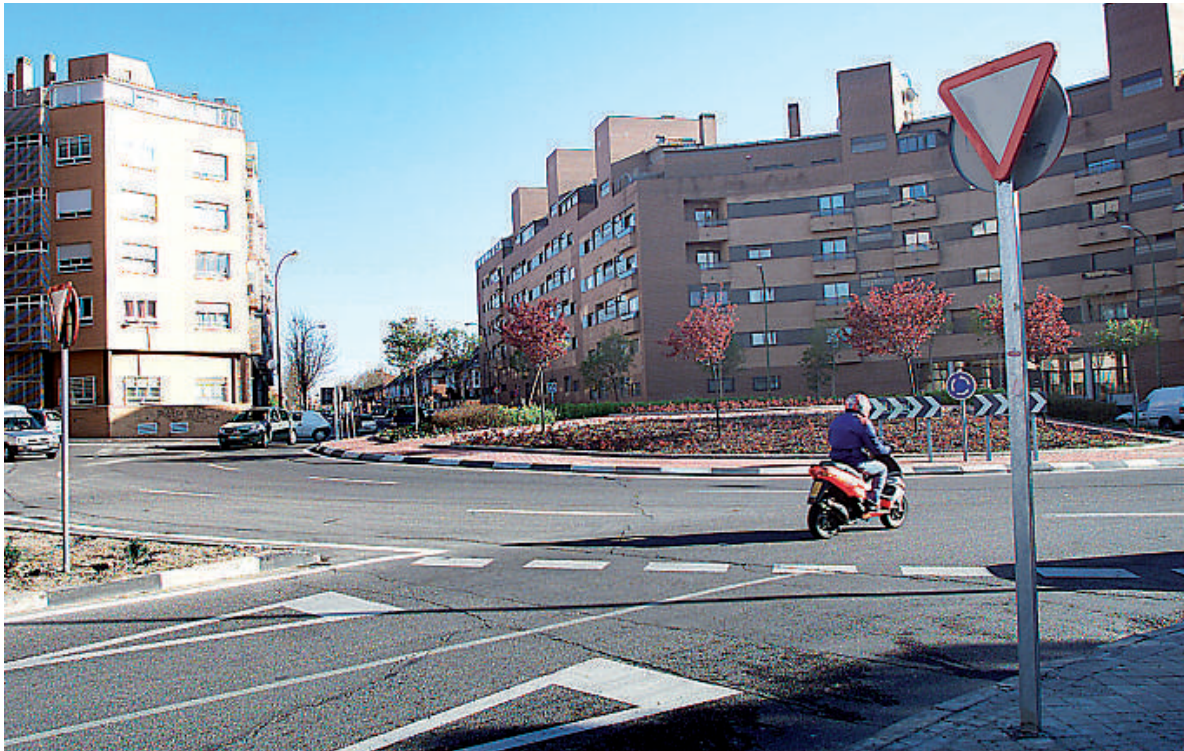
Uno de los postes de señales de tráfico que están llamados a ser sustituidos
