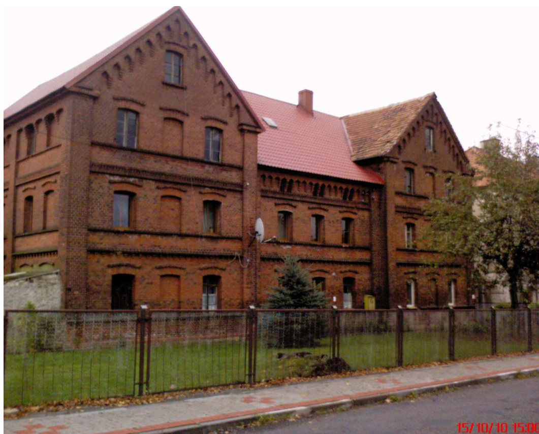
Zdjęcie nr 4. Krotoszyce – budynek mieszkalny z początku XXw. przy folwarku i pałacu.
