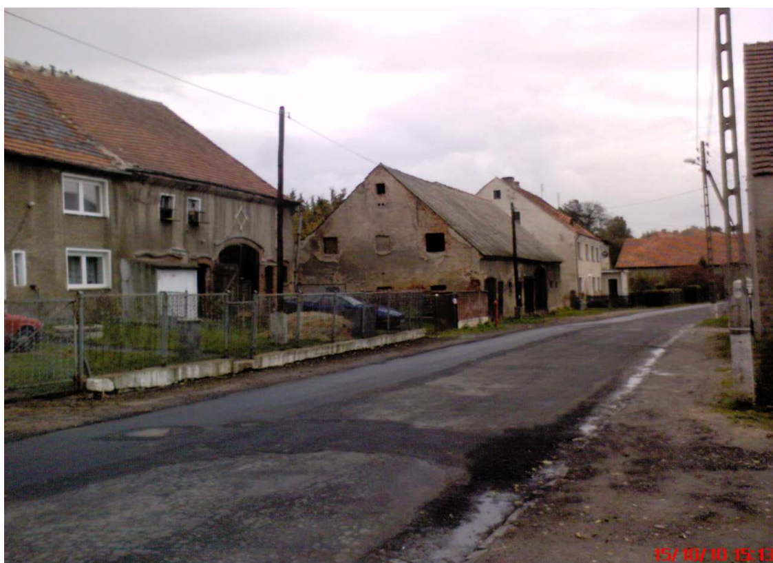
Zdjęcie nr 8. Wilczyce – widok na dawne zabudowania i ich stan zachowania.
