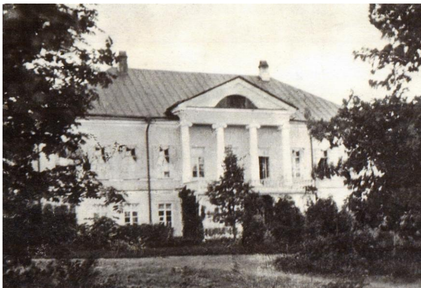
Зализенье, большой дом (теперь развалины).
