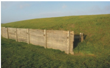
Abbildung 1a (links): Rekonstruktion eines Stackdeiches im Deichfreilichtmuseum Büsum. Abbildung 1b (rechts): Deich des Karolinenkooges von 1800. Fotos: Dirk Meier.
