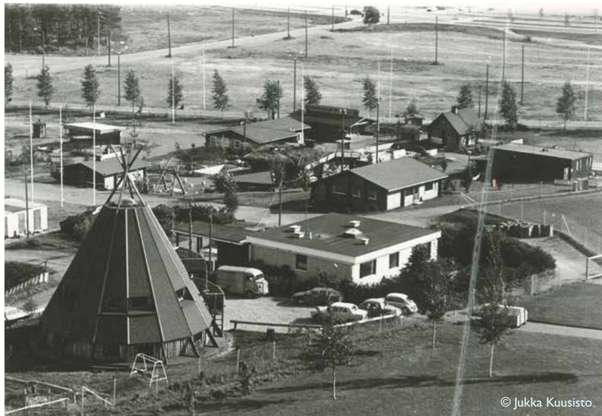
Kuva 58. Jäähallialueen vieressä sijainnut ns. "Vapaa-ajan maa" purettiin, kun Hervannan valtavyhlä rakennettiin.
