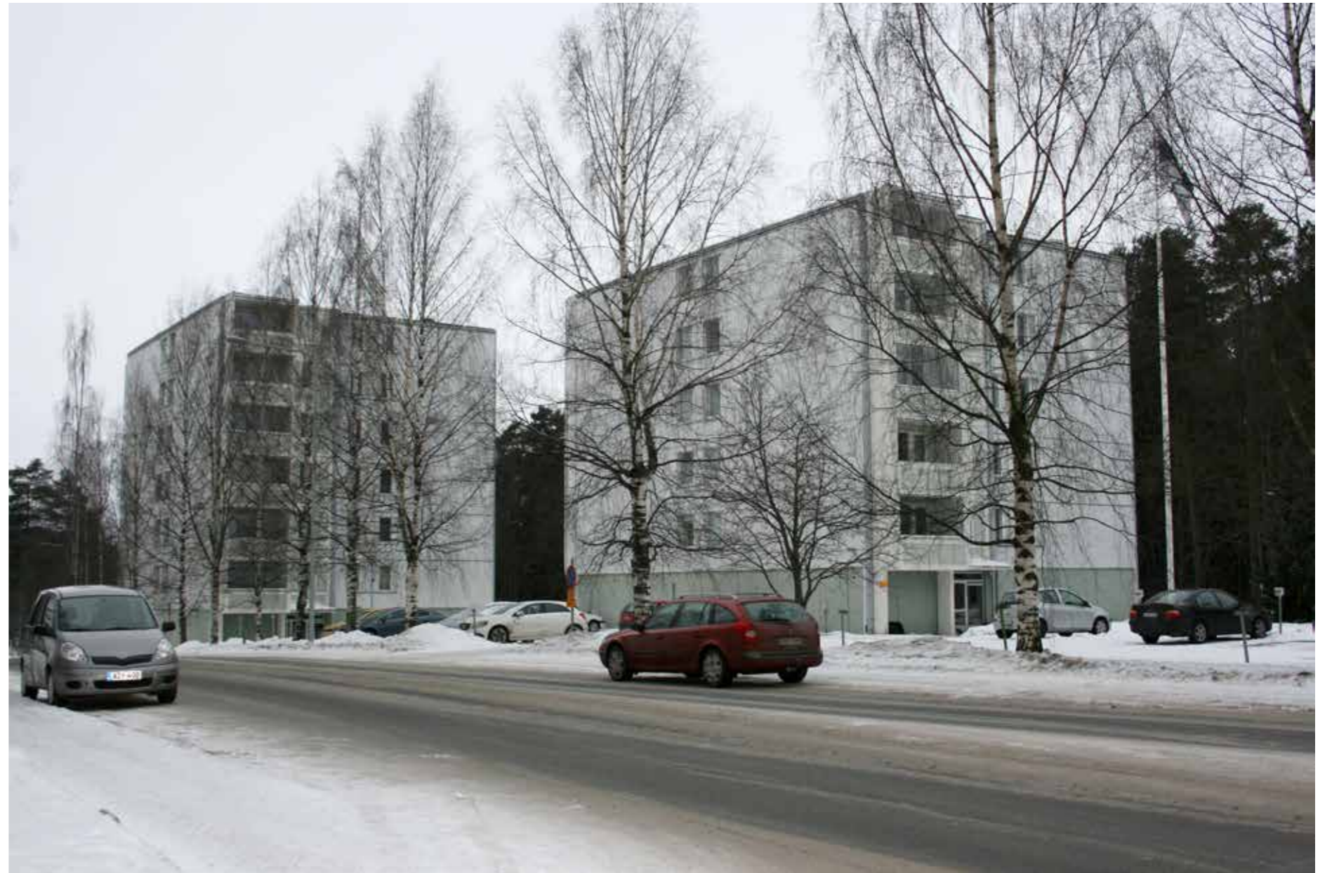
Kuva 37. Uudenkylänkatu 3:ssa sijaitsevat AUSA-elementtikerrostalot.
