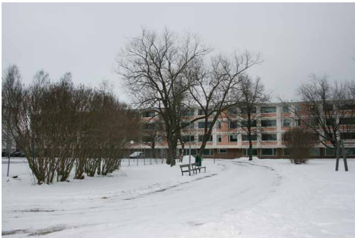
Kuva 39. Keltinkatu 4-6 Uudenmaanpuiston suunnasta kuvattuna.
