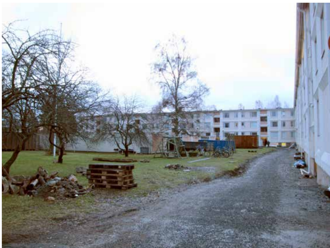
Kuva 113. Keltinkatu 4-6 sisäpiha. Kiinteistössä on meneillään remontti.
