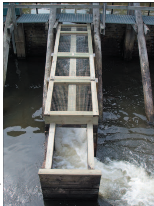
Figur 17. Ofördelaktig vinkel i utloppet (Mölnaldsån).
