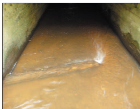
Figur 9. Exempel på "övrige fiskväg" i form av fast-satta stockar som koncentrerar strömmen i en kulvert (Taske å).
