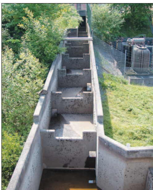
Figur 2. Exempel på en bassängtrappa med både underströms- och överfallsöppningar (Sävån, Jonsered).
