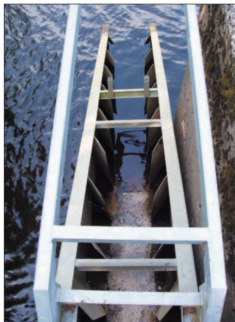
Figur 3. Exempel på denilränna (Åtran, Viskafors kvarn).
