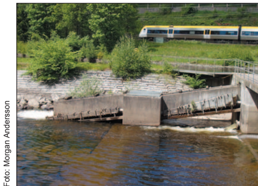
Figur 7. Ålyngelledare på utsidan av en denilränna i Säveån, Aspendammen. I detta fall är ålyngelledaren byggd helt i trä. I denna denilränna har man också anlagt en vilobassäng efter halva vägen.
