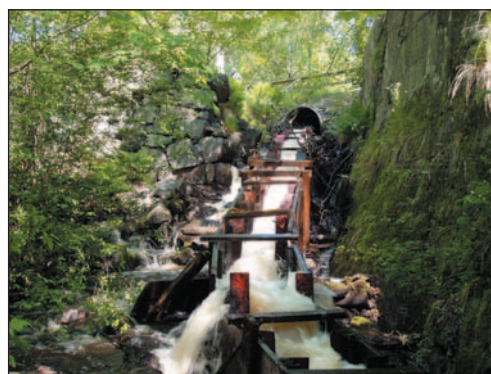
Figur 18. En vinkel på fiskvägen kan innebära en extra påfrestning på konstruktionen (Granviksån).
