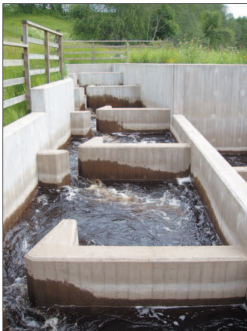
Figur 4. Exempel på hur en Slitsränna kan vara konstruerad (Ätran Vistafors kvarn).
