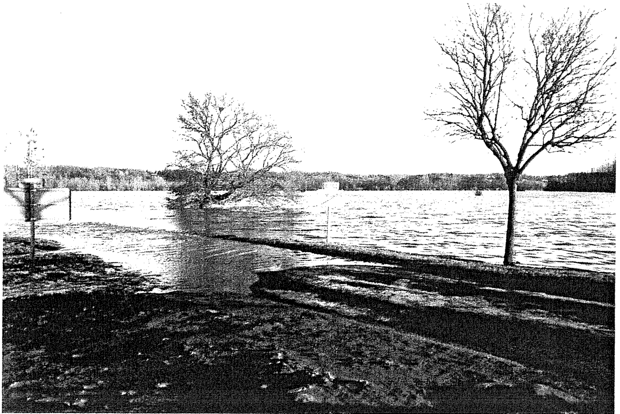
Crue du 7/12/2003 Déversoir de St Martin sur Ocre en fonctionnement
