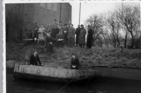
Gesamte Gruppe vor Turbinengebäude am „Schnellen Graben“
