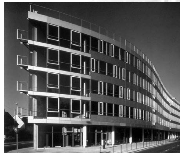
Büros und Läden formte Sabine Kirchhof in St. Leonhard zu einem Schiffsbug
