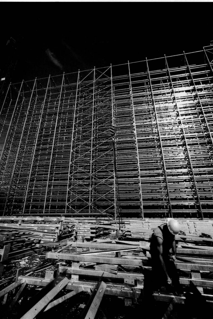
Bau des weltgrößten Logistikzentrums der grafischen Industrie am Heidelberg-Standort Wiesloch.
