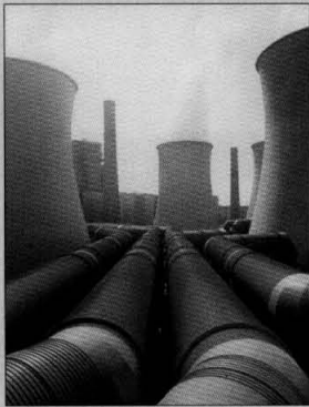
Rauchgasreinigungsanlagen im Braunkohlenkraftwerk Niederaußem, 1988
