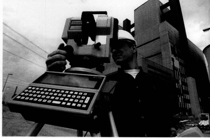
Bauvorbereitende Maßnahmen für den neuen 950-MW-Braunkohlenblock am Standort Niederaußem.
