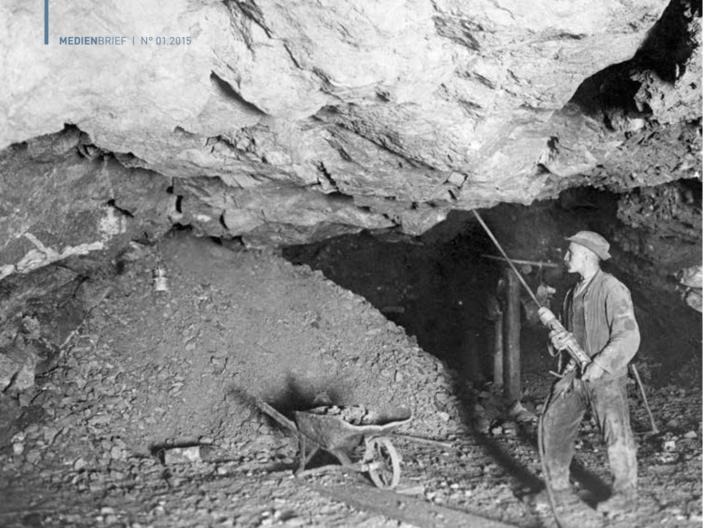
»Im Erzbergwerk: Bohren der Sprenglöcher mit Pressluft«, Glas-Dia-Positiv, s/w, Dia Nr. 19, aus: »Lichtbilder aus dem Ruhrgebiet u. seiner näheren Umgebung«, Foto: Peter Weller, um 1920
