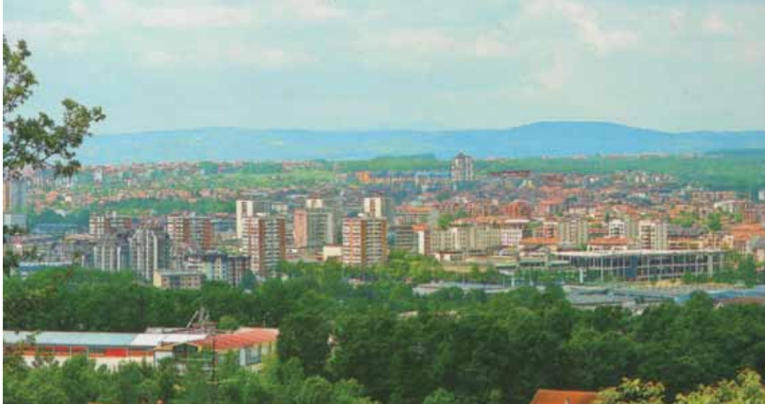
• Панорама Крагујевца: Савремено пројектована електромрежа
