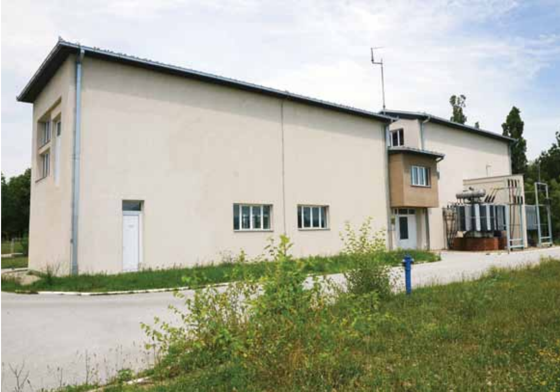
• Реконструисана трансформаторска станица код Млекаре
