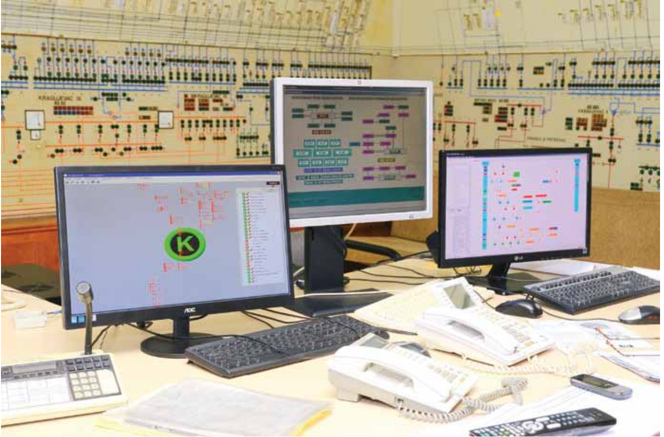
• Радно место диспечара и команде преко SCADA система
