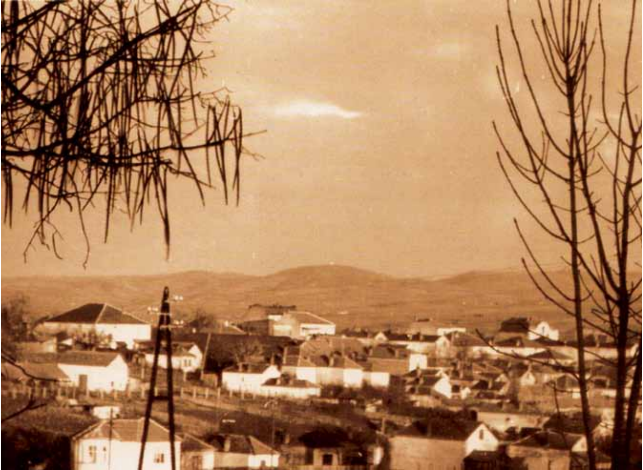
• Панорама насеља Ердоглија, које се снабдевало струјом са трансформаторске станице у Становљанском пољу
