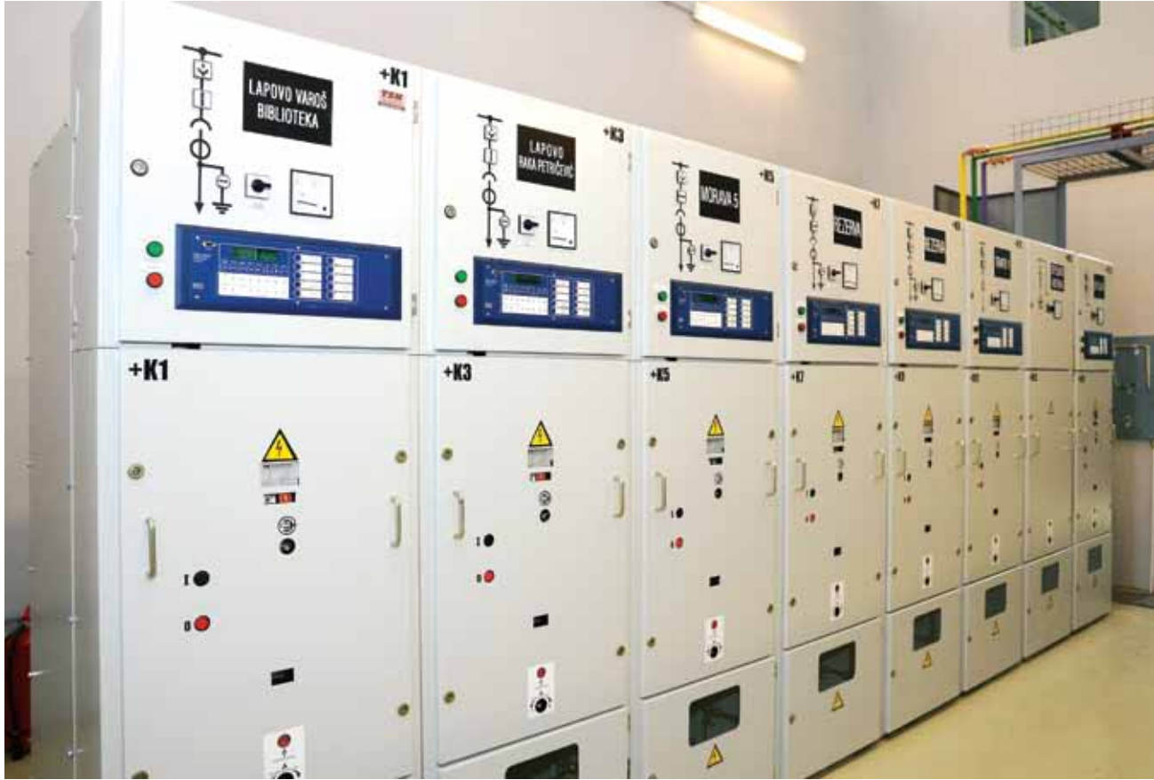
• Квалитетна реконструкција трансформаторске станице у Лапову
