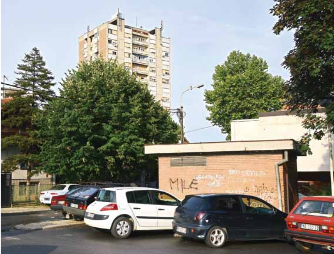
• Трансформаторска станица на Малој ваги
