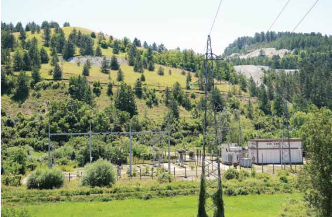
• Нова трансформаторска станица у близини Рудника „Азбест“ у Страгарима
