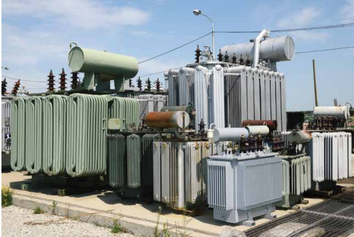
• Трансформатор 110/35 kV
