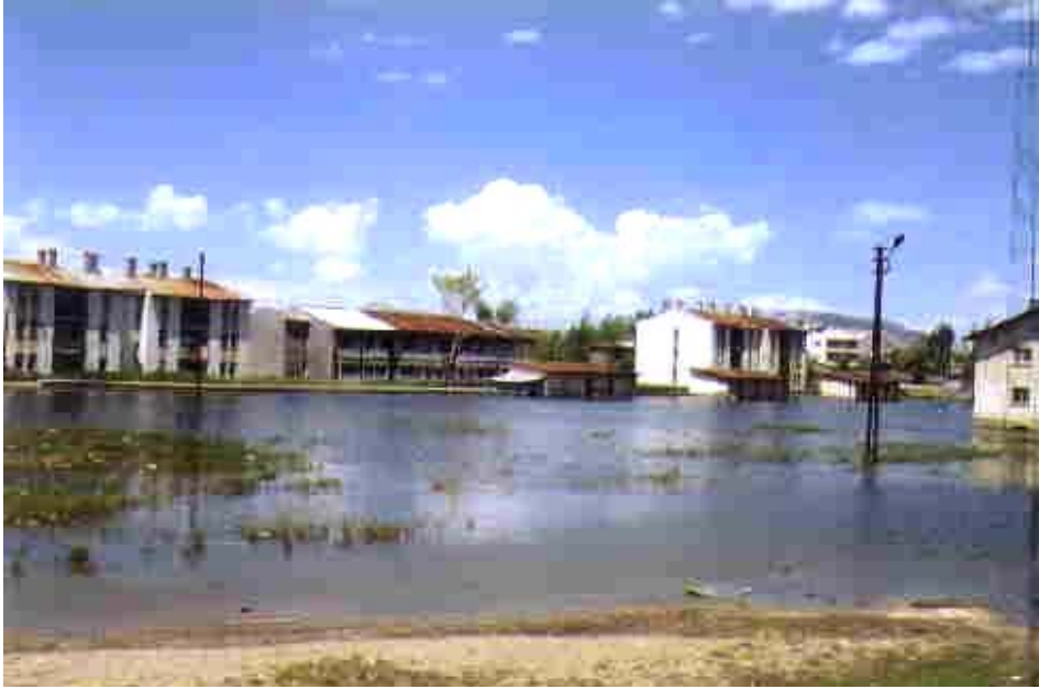
Foto 2. Van'ın İskele Mahallesinde Göl Suyu İçerisinde Kalan Evler
