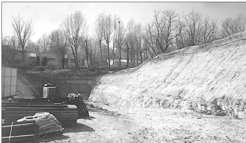
Zona de la zanja del colector entre las calles Saavedra Fajardo, Avenida de Portugal y el Paseo del Marqués de Monistrol en donde aparecieron los restos arqueológicos y paleontológicos.
