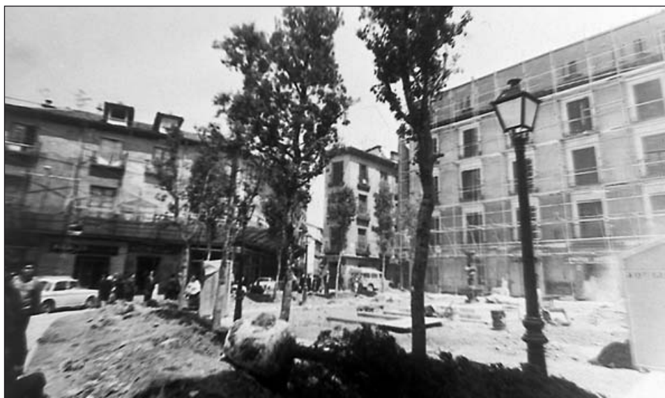
Derribo del mercado para construir una plaza. Archivo Comunidad de Madrid.
