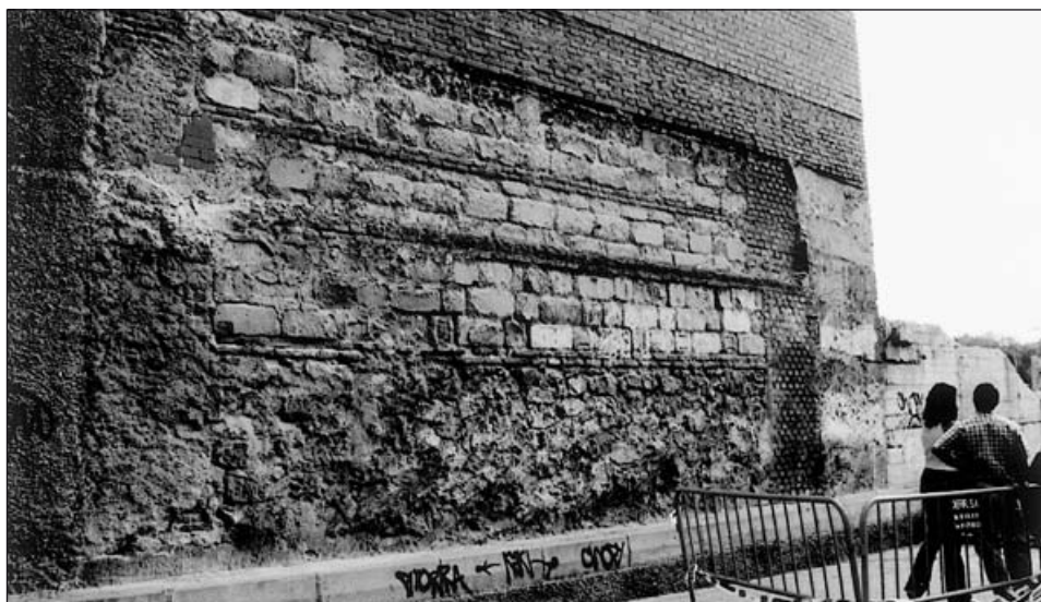
Restos de la tapia en la calle de San Crispín con la plaza de Santa Cristina antes de proceder a su restauración.
