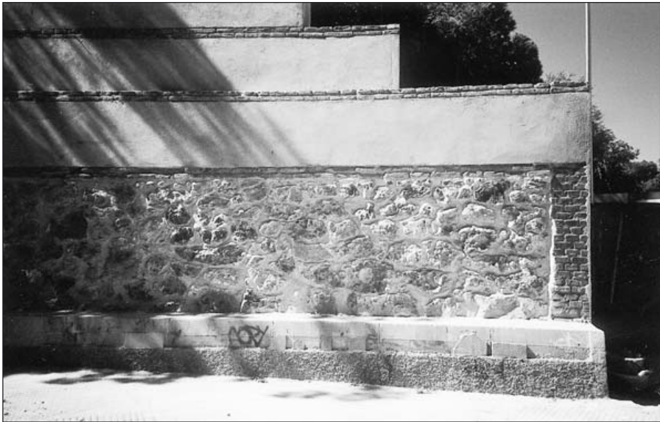
Restos de la tapia en la calle San Crispín con la plaza de Santa Cristina después de la limpieza de añadidos, restauración de las zonas originales y la recreación neutra en la zona superior.
