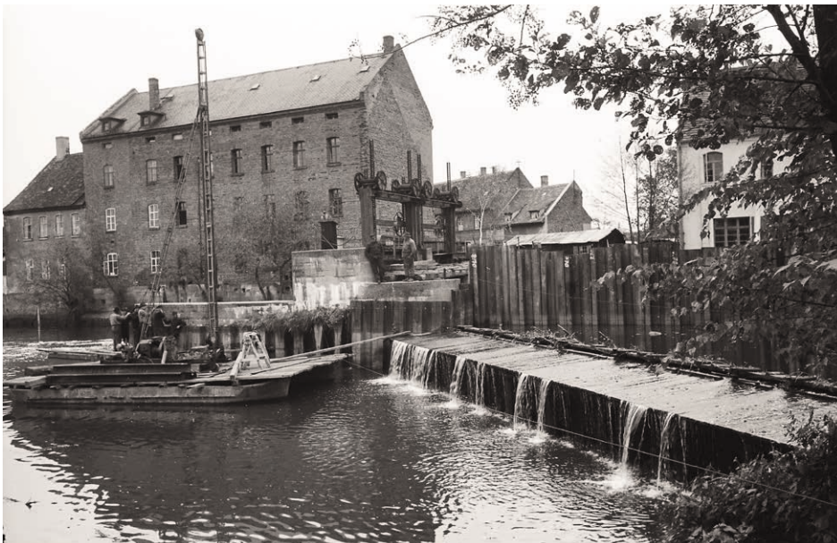
Bau eines neuen Wehrs an der Wöhrmühle, 1954. Foto: Rudi Stümpel. Stadtarchiv Erlangen
