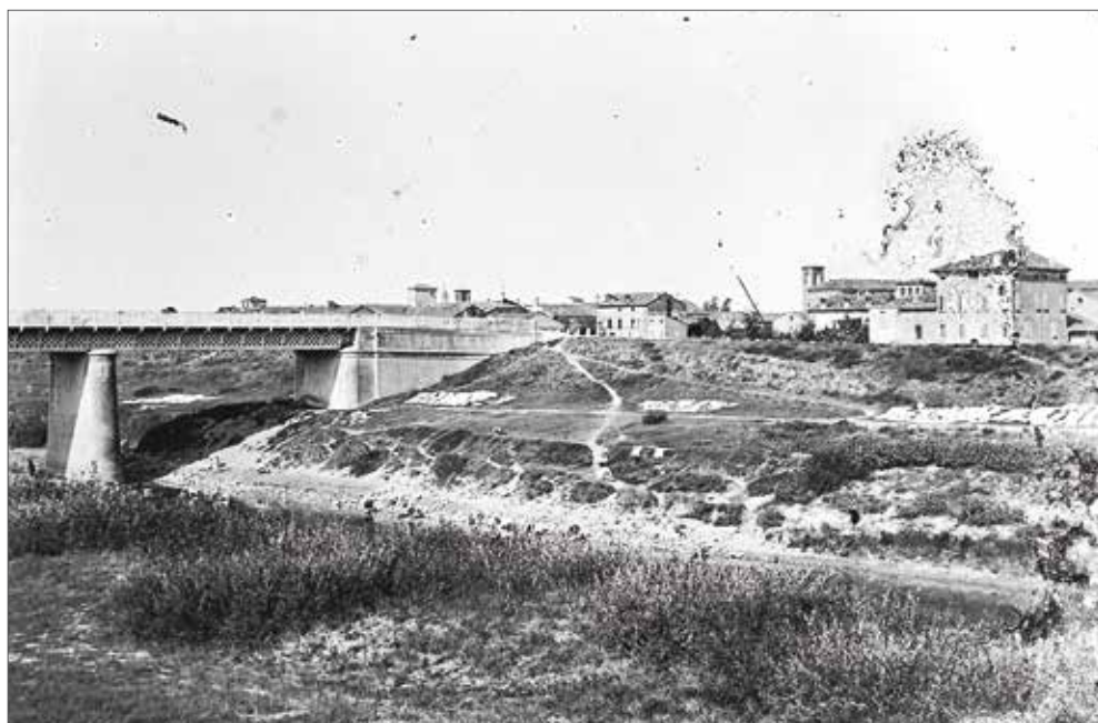
Finale Emilia. In alto, il sostegno sul canale Foscaglia e, qui sopra, il ponte sull'alveo del Cavamento (foto di Vasco Pedrazzi).
