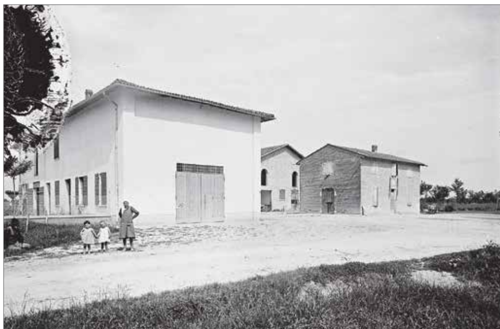
Abitazioni rurali di inizio Novecento in due immagini di Vasco Pedrazzi.
