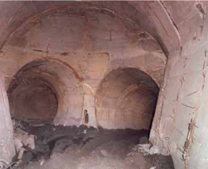
Construction des ouvrages souterrains
