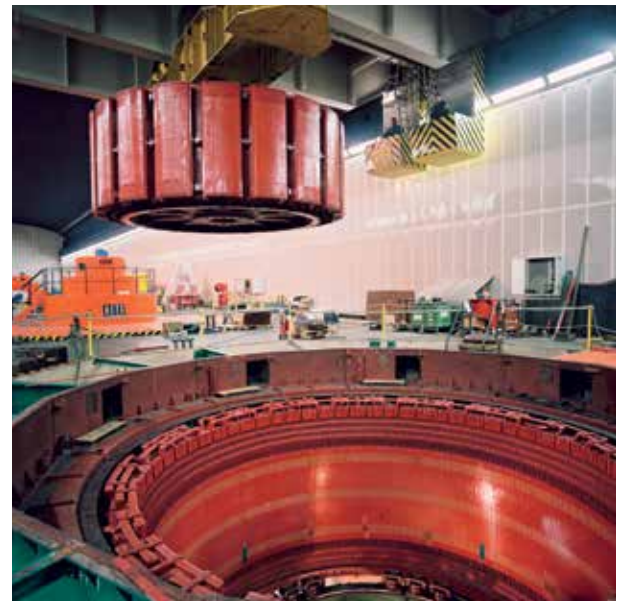
Mise en place du rotor d'un alternateur
