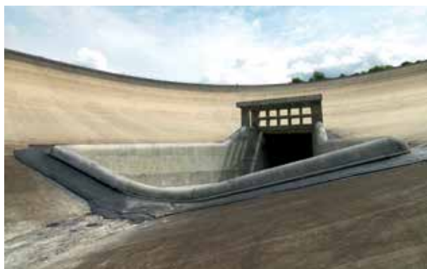
Bassin supérieur 2 et prise d'eau
