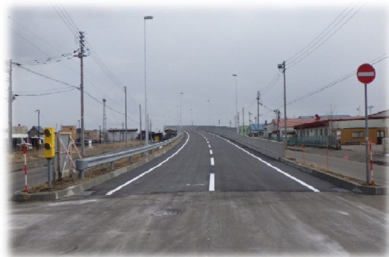
港町ふ頭こ線橋の整備状況
