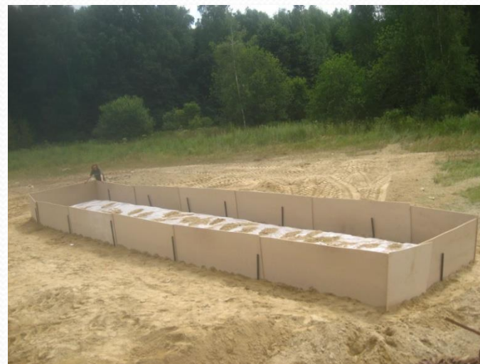
Опалубка для воздушно-механической пены
