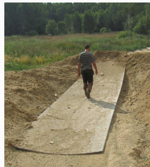
Опалубка для воздушно-механической пены
