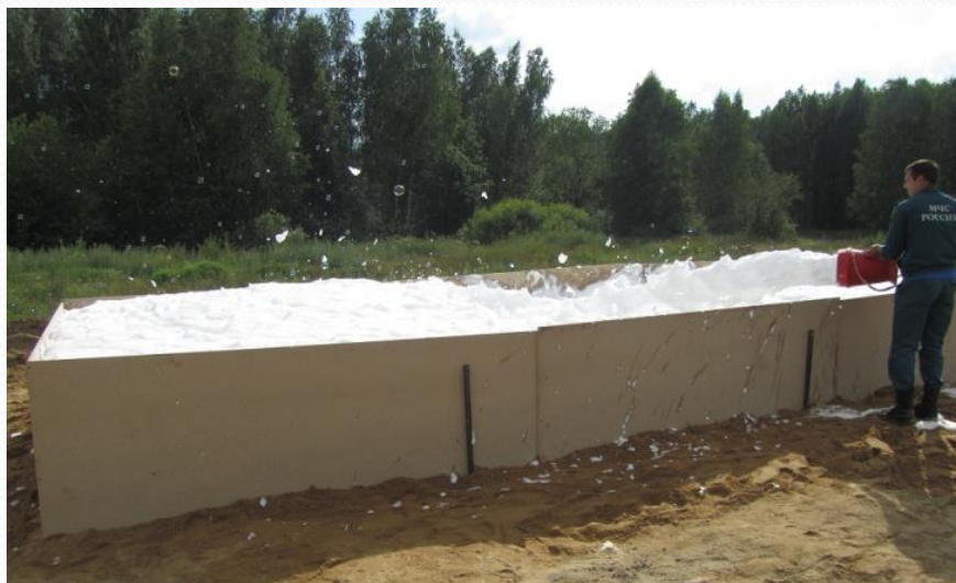
Заполнение пеной опалубки
