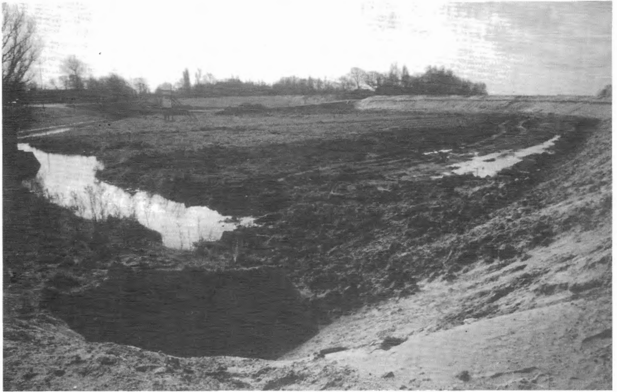
Grondwerken t.b.v. aanleg aquaduct. Foto FW. van Ooststroom.
