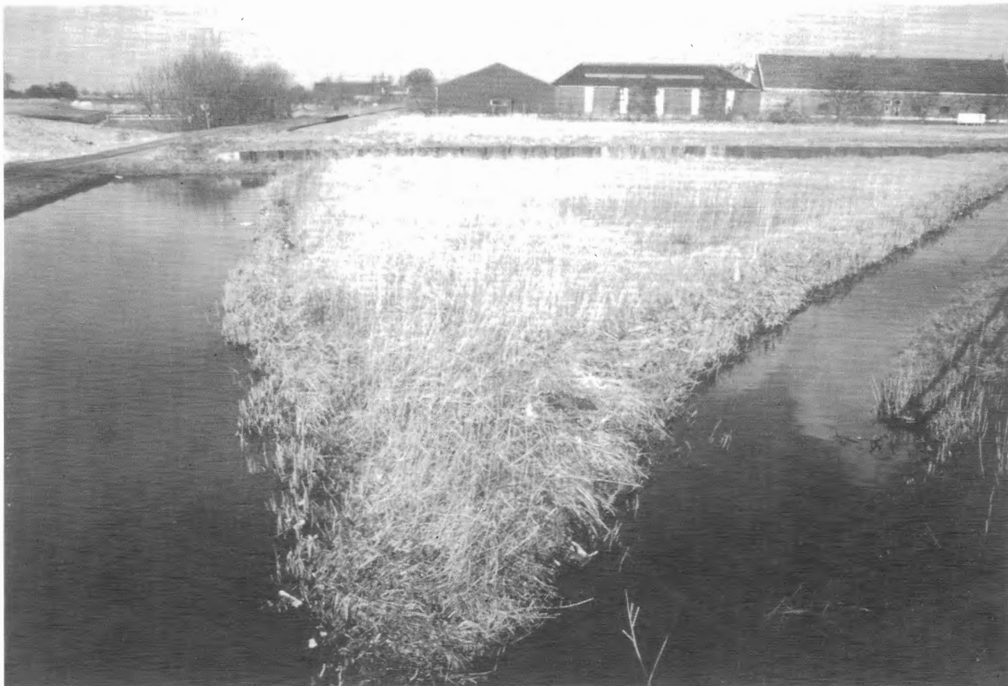
Vlietlandje aan de Rijkstraatweg met damwand t.b.v. aanleg aquaduct Rijksweg 19. Foto F.W. van Ooststroom.
