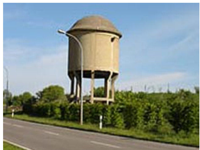
Noch heute existierender Hochbehälter für die Wasserversorgung des F-Gebietes auf dem Gelände Schacht IV Berka
