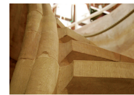
Des niches, sculptées dans des blocs de grès et aménagées le long des parois, étaient destinées à recevoir des chandelles ou lampes à huile pour éclairer la descente et le bain.
