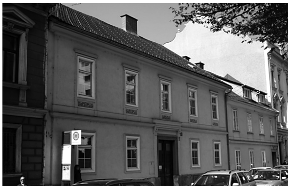
Sl. 13. Zgrada u Merangasse 24
