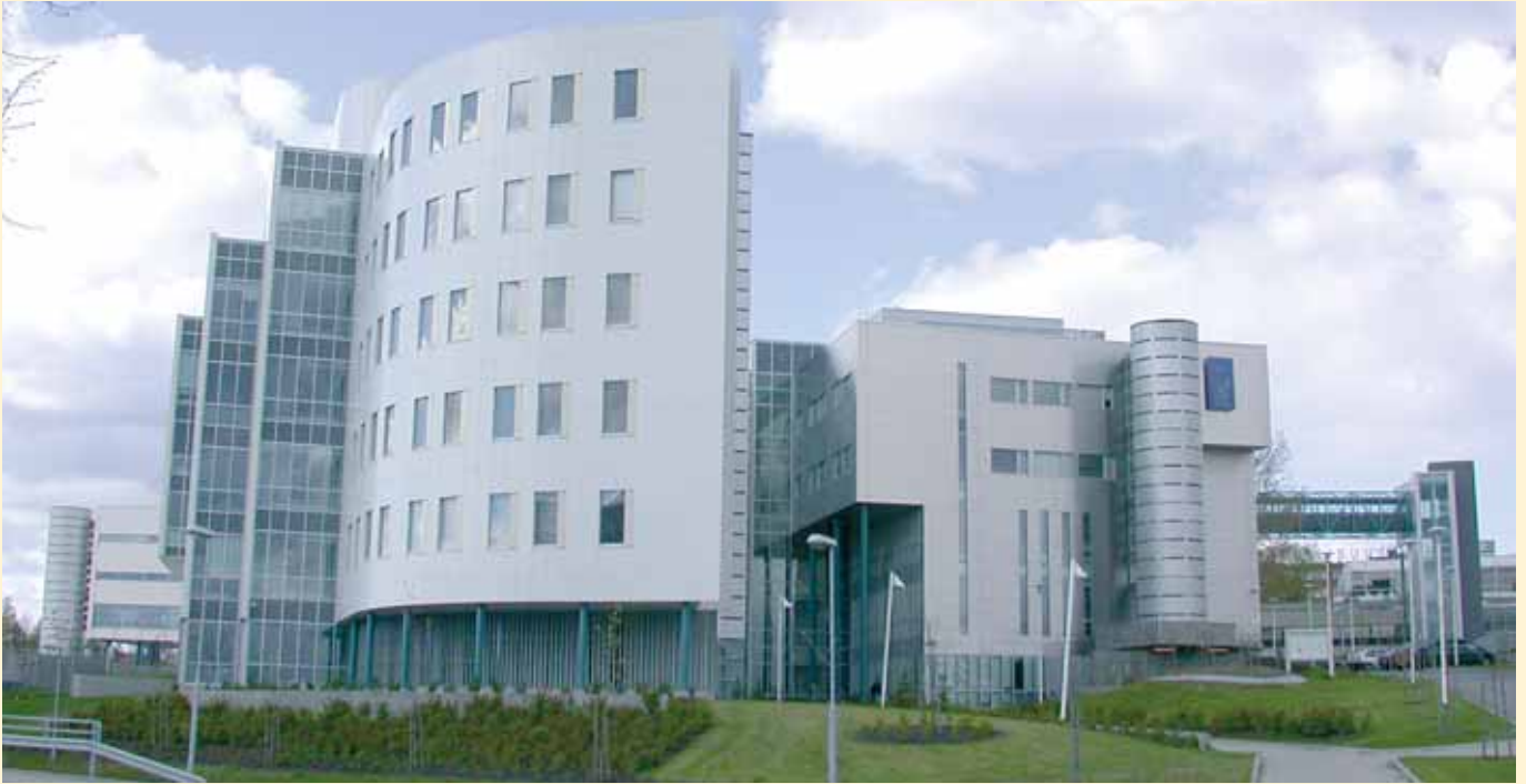
Tampereen yliopiston lisärakennus, 2003
