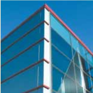
Vaakasauma korostettu värillisellä listalla.
