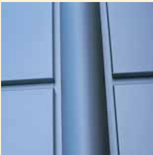
Suljettu vaakasauma Pystysauma korostettu muoto- profiililla.
