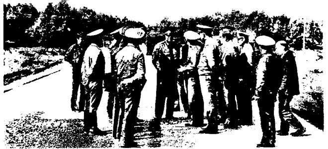
Министр обороны СССР Д. Т. Язов на строящейся дороге в Ярославской обл. Докладывает начальник дорожно-строительных частей генерал С. Х. Аракелян
