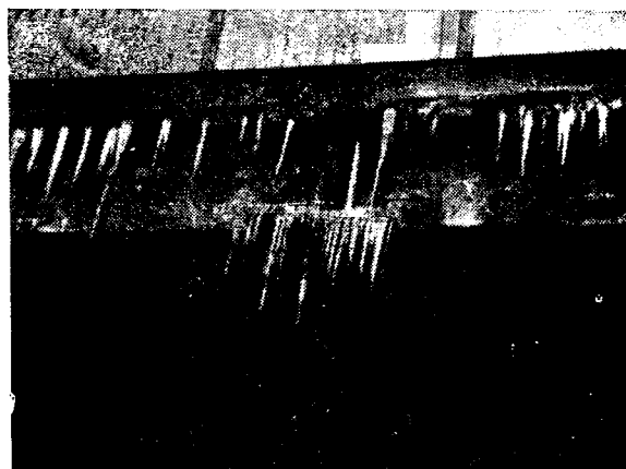
Рис. 3. Обледенение конструкций путепровода
