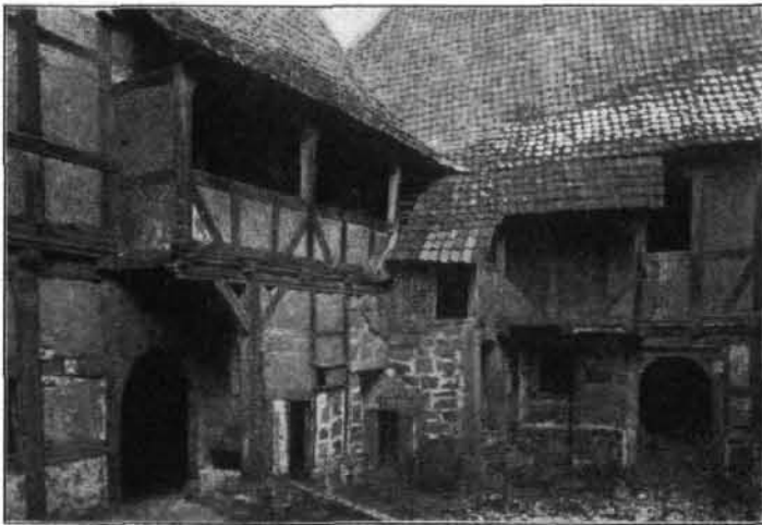
Abb. 4. Stalleingang mit Treppe und Galerie.
