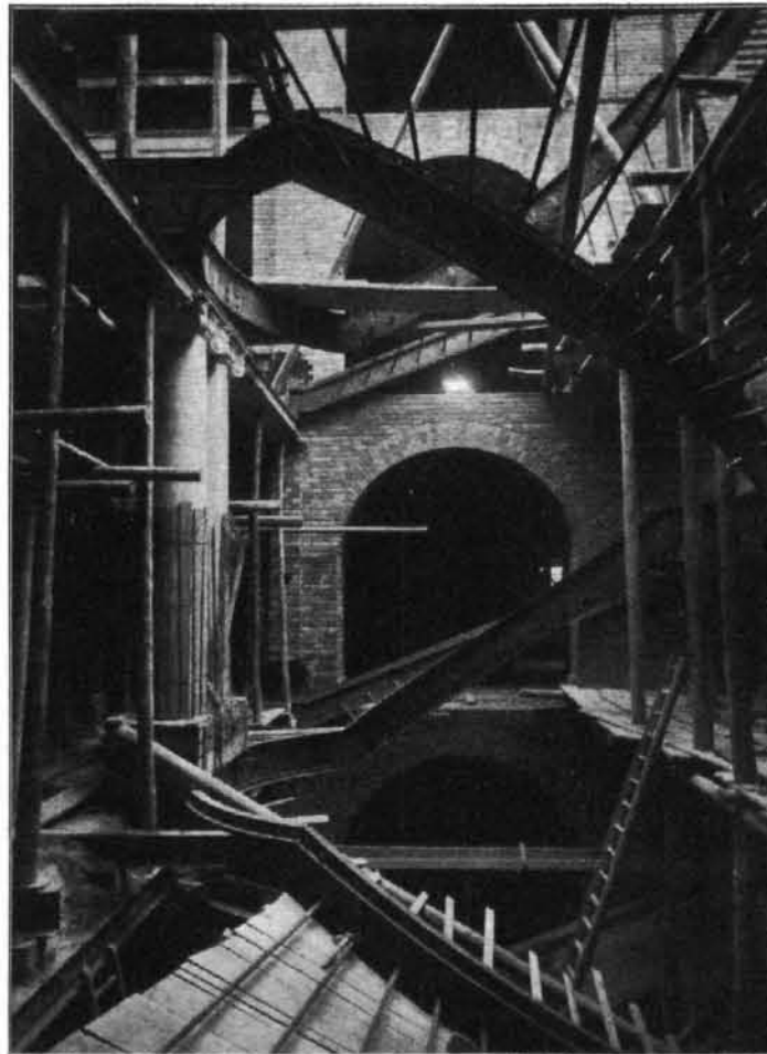
Abb. 9. Ausführung der elliptischen Haupttreppen.
