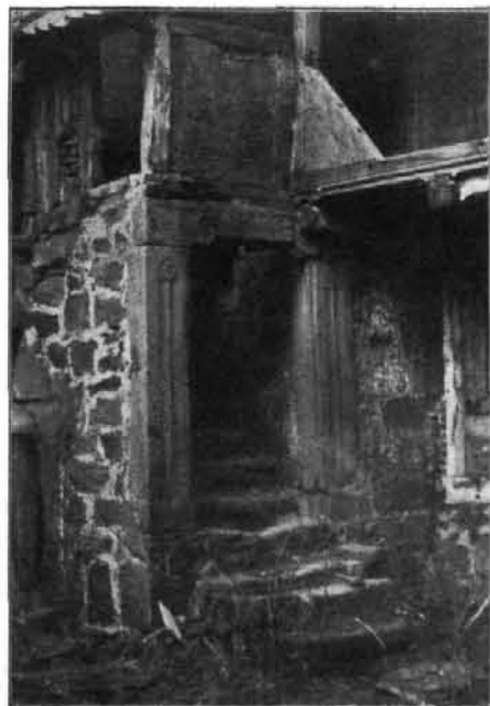
Abb. 6. Treppenaufgang zum Obergeschoß des Stallflügels.
