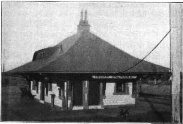
Abb. 4. Kleines Empfangsgebäude der Boston- u. Albany-Bahn.
