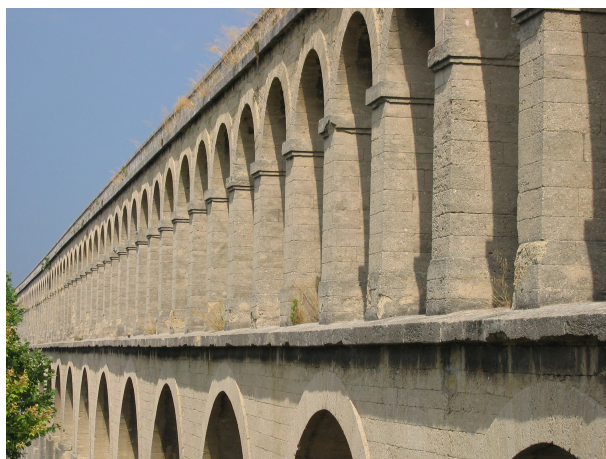
FIG. A.1 – Le pont Pitot à Montpellier
