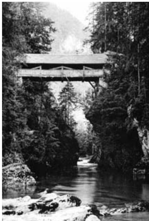
sur la rive droite: 1667. Sa structure porteuse très claire, constituée de deux poutres triangulées est inspirée par l'un des quatre modèles classiques décrits dans le traité d'architecture d'Andrea Palladio (1508–1580). A cet endroit, la gorge très resserrée permet une portée unique de 14.30 mètres. L'ouvrage qui se reflète aujourd'hui dans les eaux d'un petit lac artificiel, surplombait de plus de 16 mètres les flots tumultueux de la Sarine.
