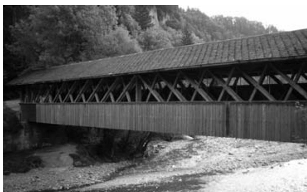
Fig. 19 (en bas): Le pont de Sodbach, charpente selon le système de l'ingénieur américain William Howe (Photo: P. Zwick).
